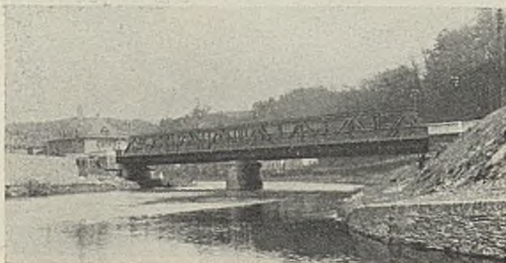
Abb. 41. Lahnbrücke bei Weilburg.
