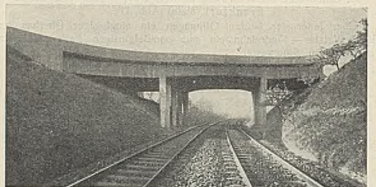
Abb. 50. Überführung der Zeppelin-Straße in Stuttgart.
