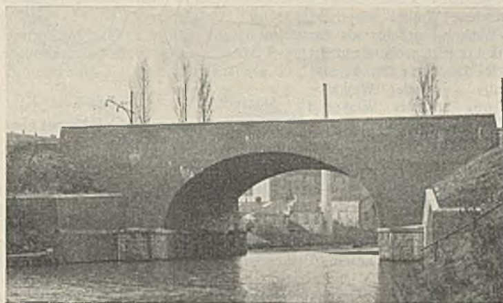
Abb. 52. Zweigleisige Brücke über den Osterbeck-Kanal in Hamburg.
