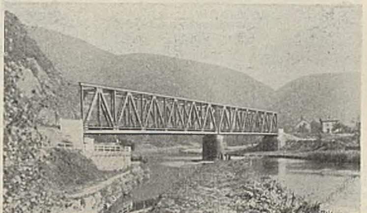
Abb. 43. Lahnbrücke bei Hohenrhein.
