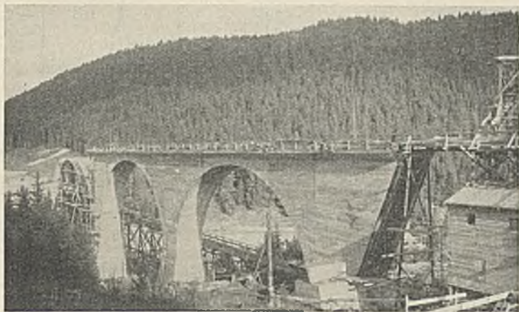
Abb. 51. Eingleisige Brücke über das Einödtal.
