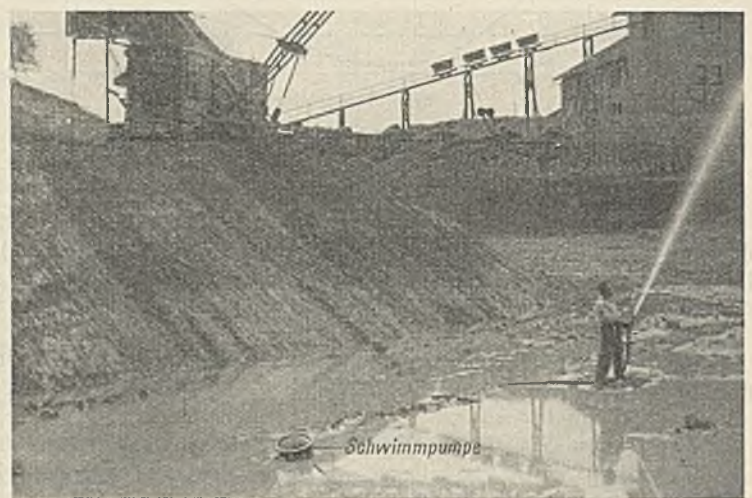
Abb. 2. Schwimmpumpe in einer Baugrube.
