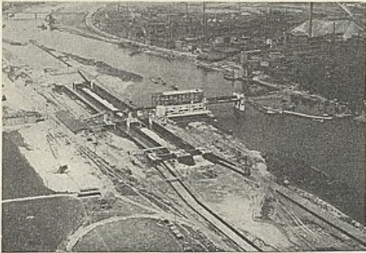
Abb. 34. Luftbild der Staustufe Griesheim.
