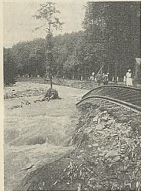
Abb. 6. Schienenabbruch zwischen Antonsthal und Breitenhof.
