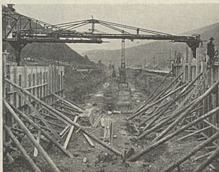
Abb. 40. Staustufe Rockenau. Schleusenbaugrube.
