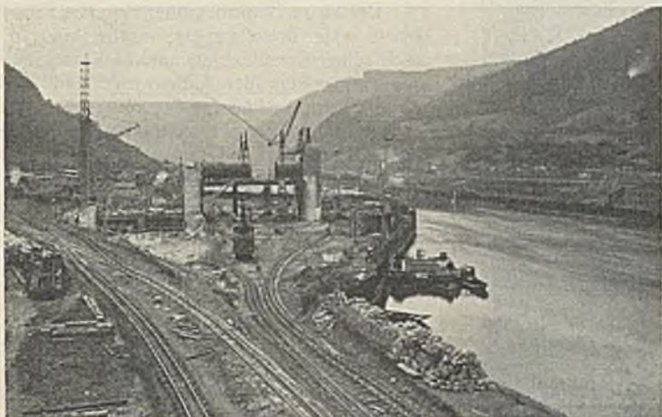
Abb. 39. Staustufe Rockenau. Gesamtanlage im Bau vom Unterwasser aus.
