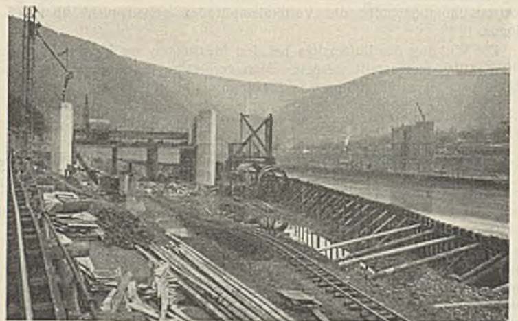
Abb. 38. Staustufe Hirschhorn. Gesamtanlage im Bau vom Unterwasser aus.
