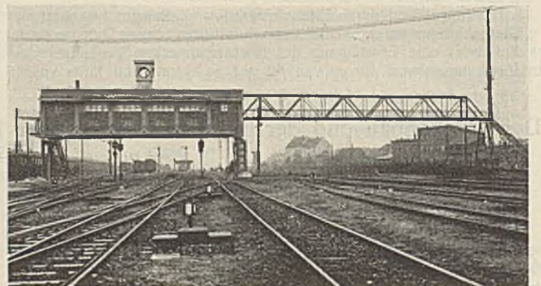
Abb. 60. Stellwerksgebäude auf Bahnhof Stendal.
