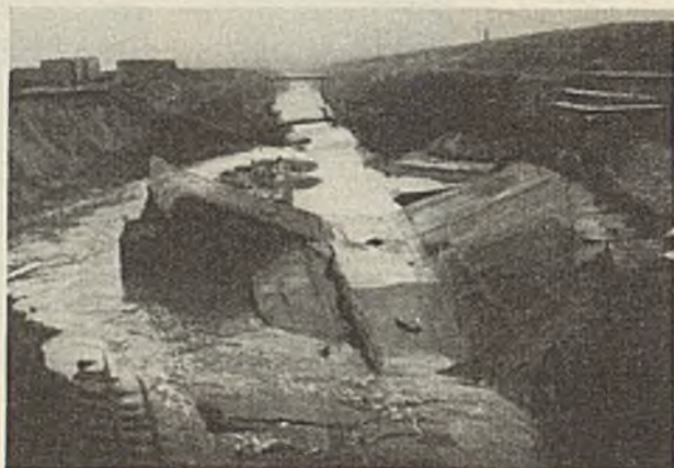
Abb. 14. Bauarbeiten zur Ermäßigung des Hüllerbachabsturzes um 2 m bei km 2,4 + 76.
