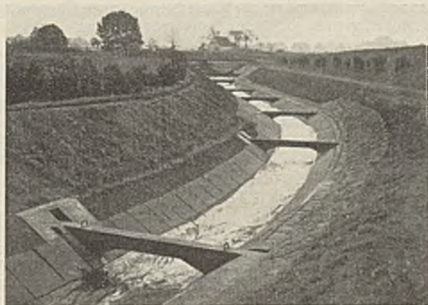
Abb. 27. Die Schußstrecke unterhalb der Kaskade nach Einbau der Wasserbremsen bei NW.
