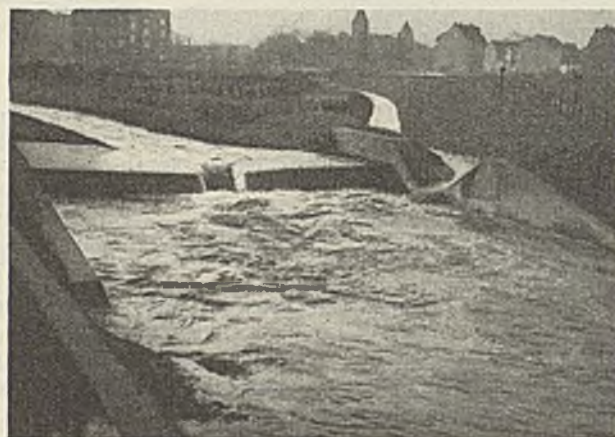
Abb. 13. Absturz im Emscherlauf bei km 58 + 95 bei kleinem Hochwasser.
