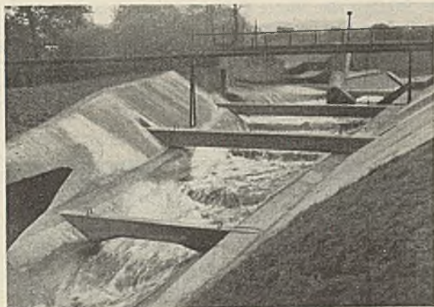
Abb. 26. Die Kaskade nach Einbau der Wasserbremsen bei NW.
