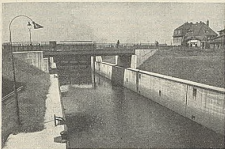
Abb. 8. Ansicht der Schleusenkammer vom Binnenhaupt aus.
