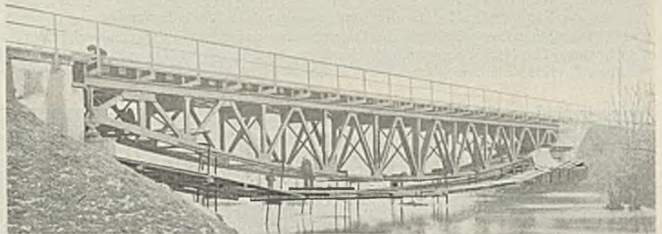
Abb. 17. Gesamtansicht der Brücke mit der Hängerüstung für die Untergurt-Verstärkung.
