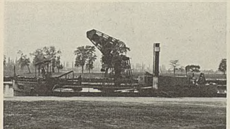
Abb. 46. Felsmeißelschiff für Lösen von Fels unter Wasser. Oberer Aufbau in Kipplage.
