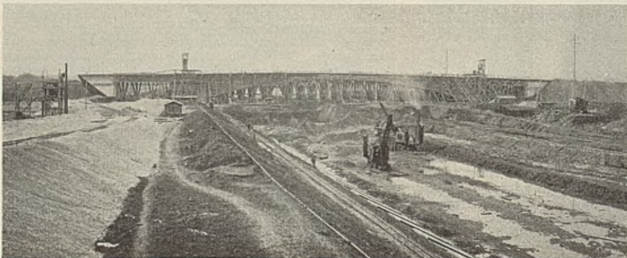
Abb. 43. Staustufe Heilbronn. Staatsstraßenbrücke und Neckardurchstich vom Unterwasser aus.
