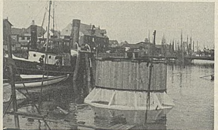
Abb. 6. Senkkasten für die Leuchtbake „Oste“ beim Ablafen von der Aufschleppe.
