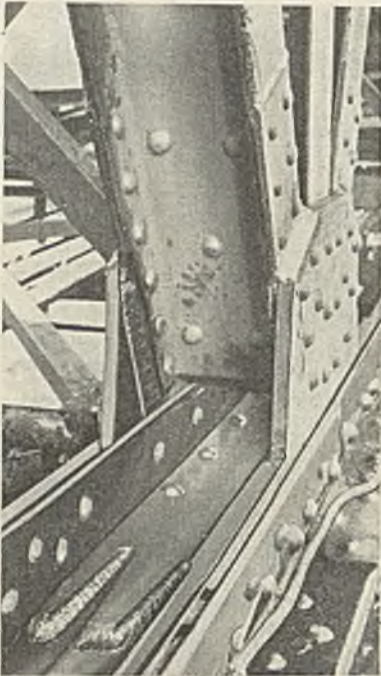
Abb. 6. Verstärkter Anschluß einer mittleren Diagonale und Fingerlasche des Untergurtes von oben.
