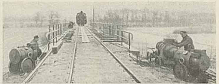
Abb. 15. Aufstellung der Schweißgeneratoren.
