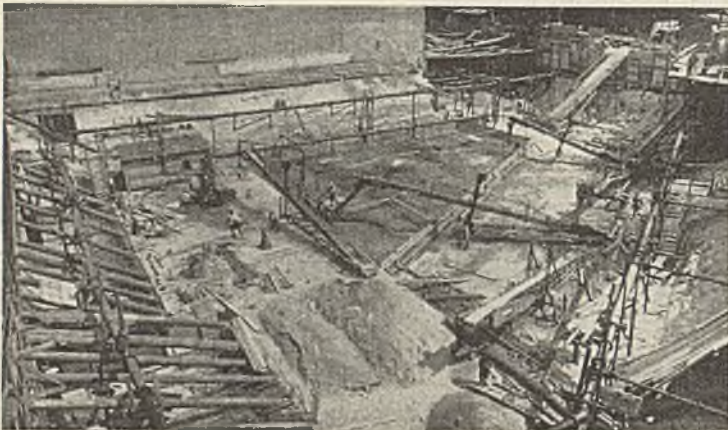
Abb. 11. Die Baustelle am 13. Juni 1930. Betonieren des Blockes IX.
