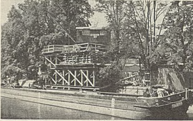
Abb. 10. Der Greiferkran am Ufer des Landwehrkanals beim Umschlagen des Kiesel.
