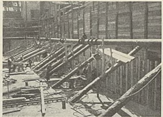
Abb. 7. Die Absteifung der I-Träger der Umschließung gegen die fertige Sohlenplatte.
