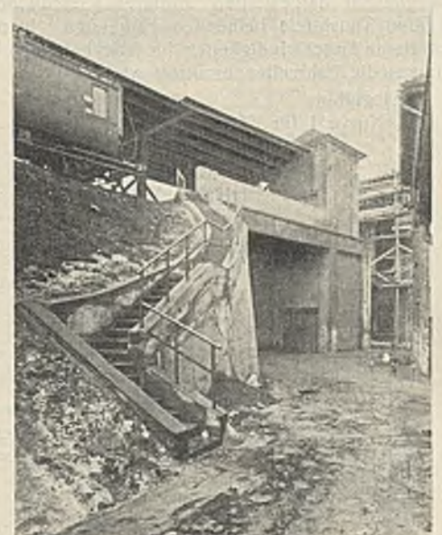
Abb. 9. Blick vom bahnsseitigen Tor des Eilgutschuppens auf Aufzug I.
