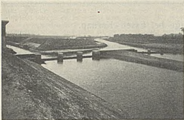
Abb. 4. Das Wehr von Unterwasser gesehen. Rechts Emscher, links Boye. Links der durch Dammbalken verschlossene Grundablaß.
