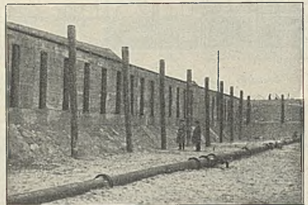
Abb. 14. Eisenbetonstützmauer an der Zulaufseite mit Schlitzen für den Wassereintritt. In der Mitte durchgehende Trennungsfugen. Vor der Mauer die Rammpfähle, die die Holzkonstruktionen tragen sollen. Vorn die Hauptstaffel der Wasserhaltung. Die Beckensohle ist unbefestigt.
