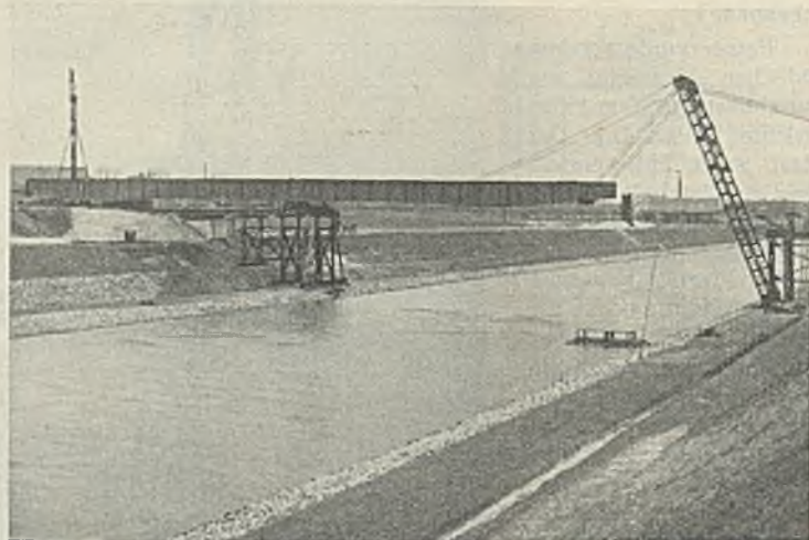
Abb. 9. Das freie Ende der Brücke wird durch den Portalmast aufgefangen.
