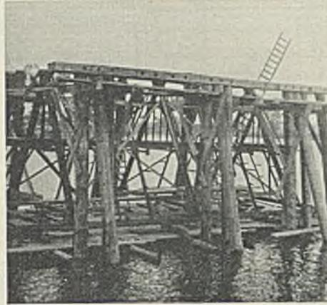
Abb. 8. Eisengerippe des Senkkastens des Pfeilers E (von der Seite gesehen) und Absenkgerüst.
