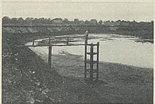
Abb. 25. Blick in einen Schlammplatz, hinten die Schlammleitung, vorn Entwässerungsturm mit schwimmender Tauchwand.
