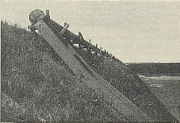
Abb. 24. Schlammleitung mit Blechluten in einem Schlammbecken.
