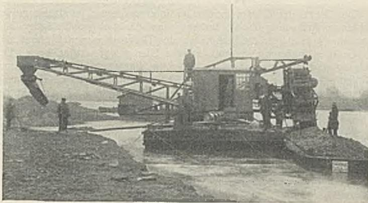
Abb. 1. Gurtförderer auf dem linken Ufer arbeitend. Eimerleiter nach oberstrom.
