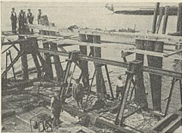
Abb. 13. Eisengerippe des Ringsenkastens und Absenkerüst im Bau.
