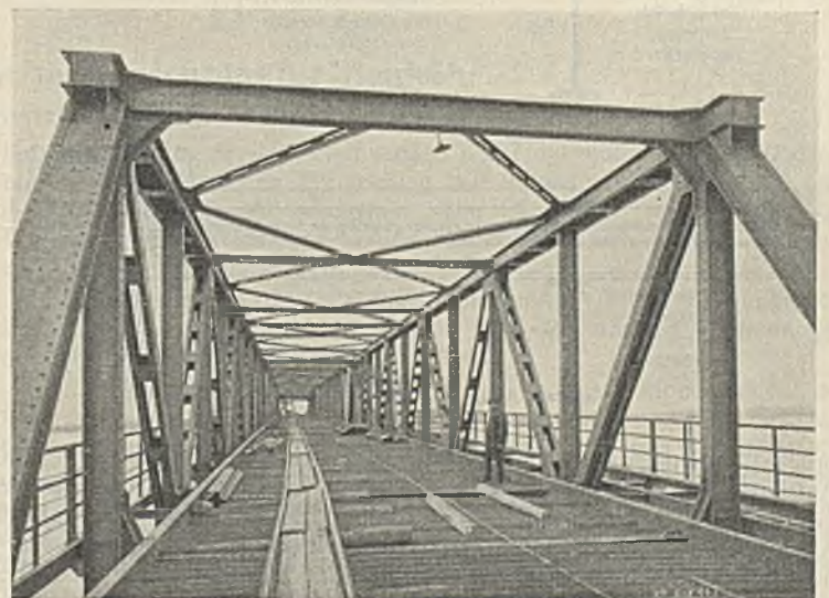
Abb. 20. Blick in die Brücke während der Montage.
