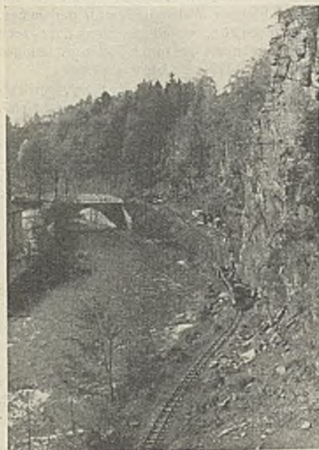
Abb. 7. Felswand bei km 0,12.
