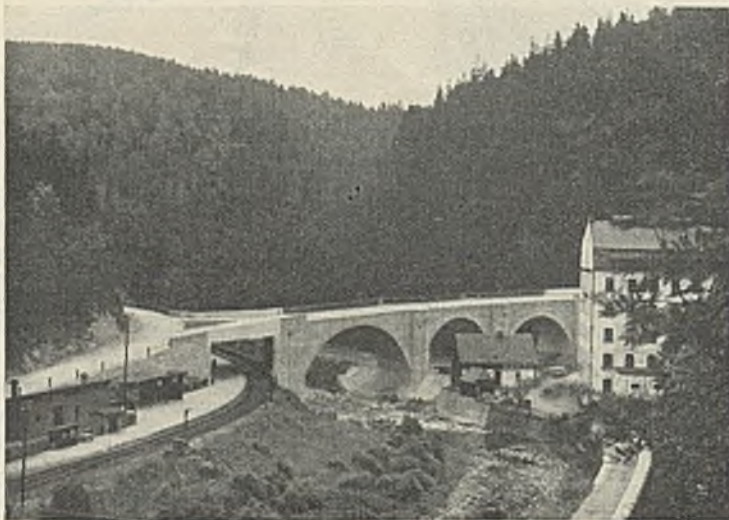
Abb. 4. Talbrücke an der Haltestelle Floßplatz „Warmbad“, von oberstrom gesehen.
