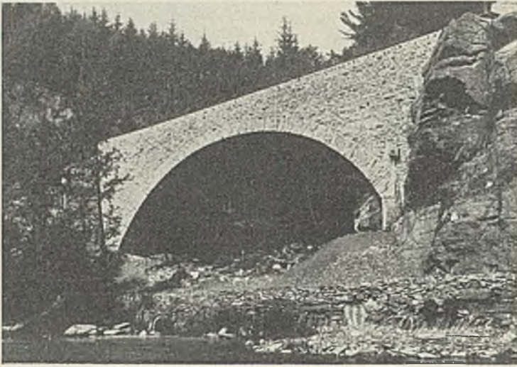
Abb. 11. Bedelbachbrücke bei km 0,9.
