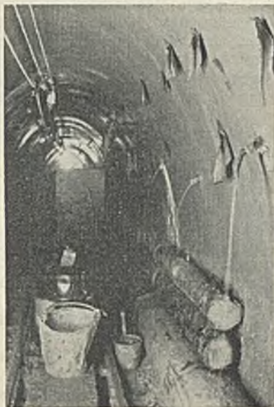
Abb. 28. Abdichtungsarbeiten am Verputz.
