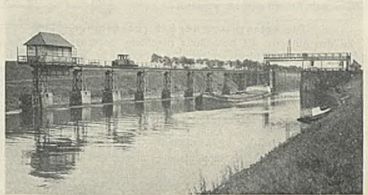
Abb. 6. Schleppanlage an der Schleuse des Rhein-Herne-Kanals.
