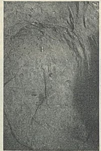
Abb. 22. Vortrieb im Trockenem. (Grüner Flienz.)
