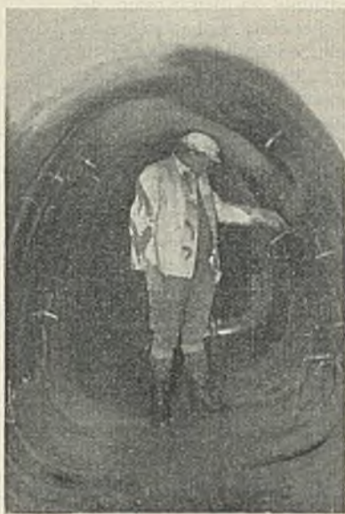
Abb. 27. Abdichtungsarbeiten am Verputz.
