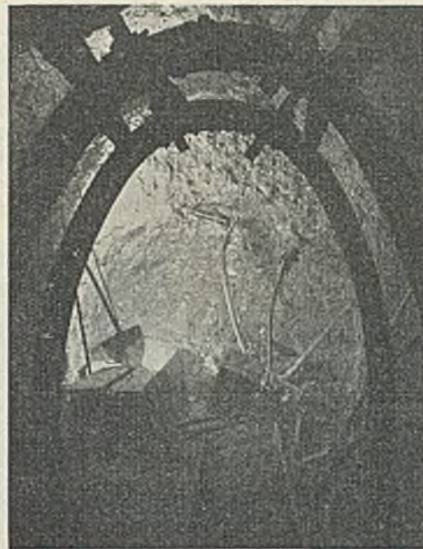
Abb. 21. Vortrieb im Trockenem. (Kies und Nagelfluhe. Rechts Bohrmaschine, links Abbauhämmer.)
