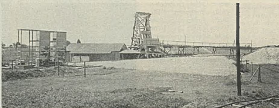
Abb. 13. Baustelle Schacht Darching.
