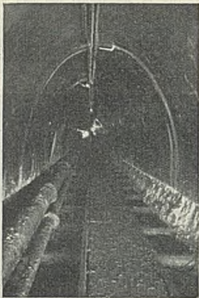
Abb. 20. Stollen während des Vortriebs. (Sohlenbeton noch nicht eingebracht.)
