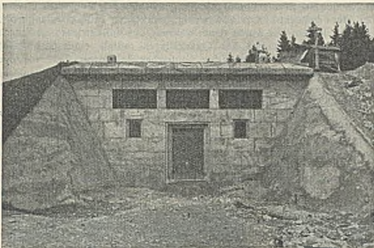
Abb. 33. Schachtportal mit Tuffsteinverkleidung.
