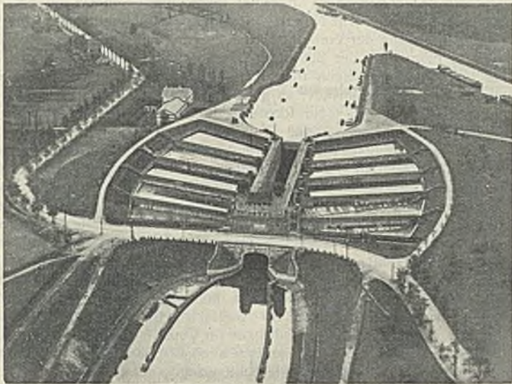
Abb. 4. Schachtschleuse Henrichenburg am Dortmund-Ems-Kanal.
