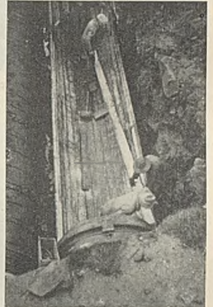
Abb. 10. Fertigbau der oberen Anschlußmuffe.
