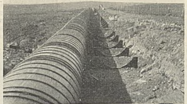
Abb. 5. Ausrichten der Rohrsättel.
