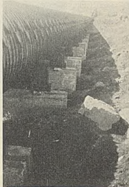
Abb. 9. Betonsockel.
