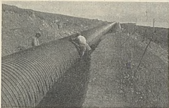
Abb. 8. Streichen der Leitung.
