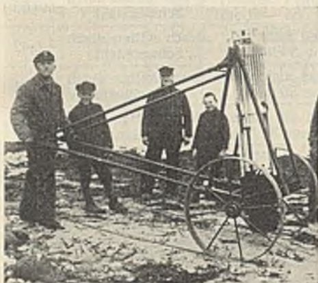
Abb. 1. 200-kg-Explosions-Pfahlramme auf einem Fahrgestell.
