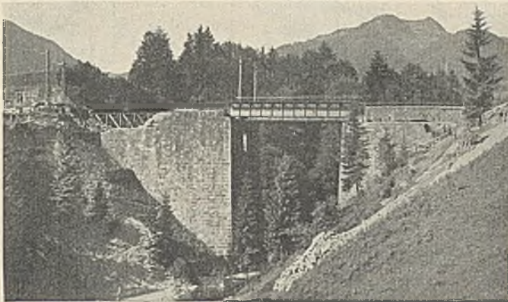
Abb. 1. Umzubauende Brücke vom Jahre 1873. Die Bahn liegt 30 m über Talsohle. Im Hintergrunde der Wildseeloder.
