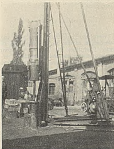
Abb. 2. 600-kg-Explosions-Pfahlramme.
