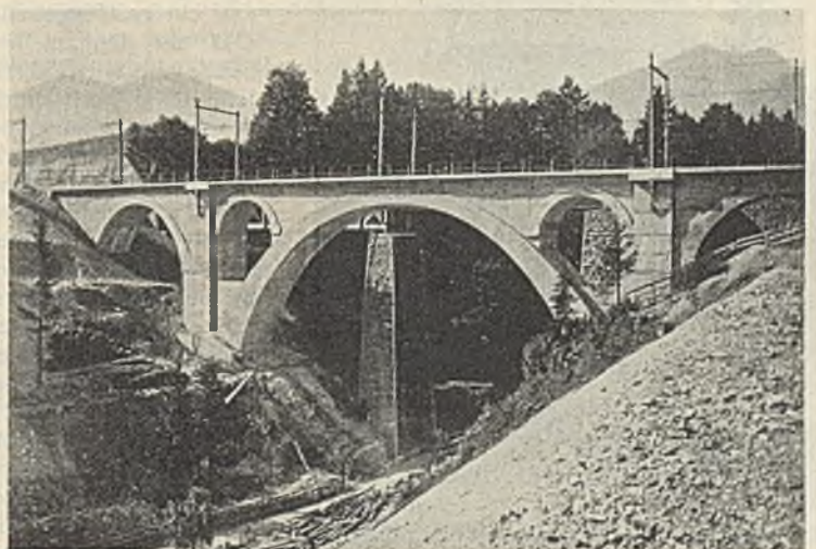
Abb. 10. Das fertige Bauwerk. Dahinter die Pfeiler im 2. Gleis.
