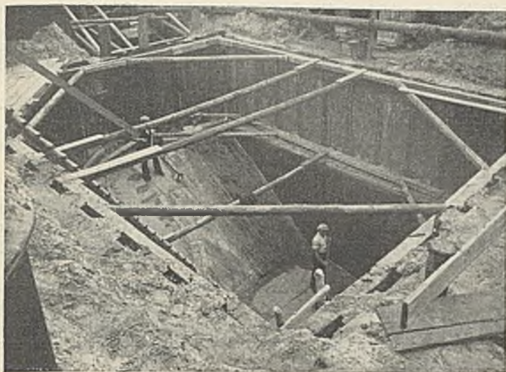
Abb. 6. Äußere Isolierung des Pumpensumpfes.
