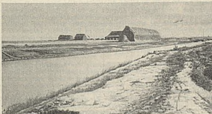
Abb. 13. Fertiggestellter Kanal De Haukes. Schleuse I mit Uferbefestigung (September 1931). Im Hintergrunde Scheunen und Strohhaufen.
