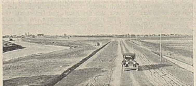
Abb. 14. Teerschlackenstraße und Hauptkanal bei De Haukes, gesehen in Richtung auf Wieringen. Breite des Straßenkörpers 15 m, Breite der Befestigung 3,5 m.
