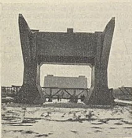
Abb. 9. Endwiderlager der Donaupfahlbrücke.
