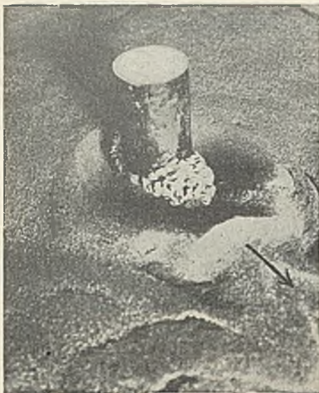
Abb. 5. Sohlenbefestigung unterhalb des Pfeilers.
