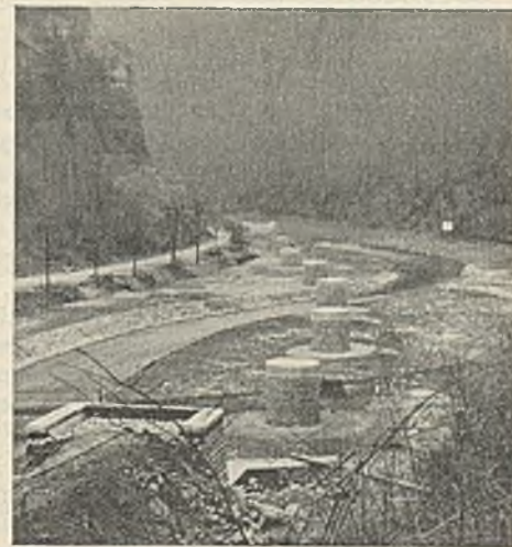
Abb. 14. Der fertige Brückenunterbau.
