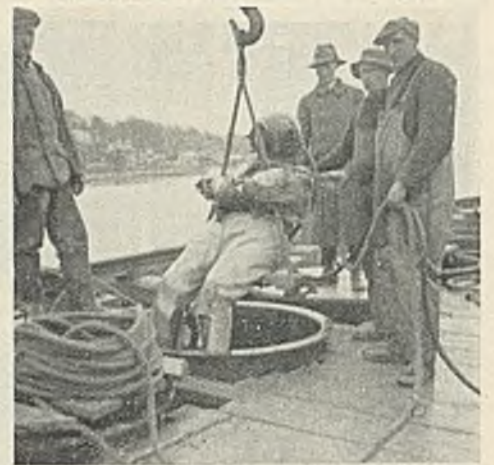
Abb. 7. Ein Taucher wird in einen Hohlpfahl hinuntergelassen.
