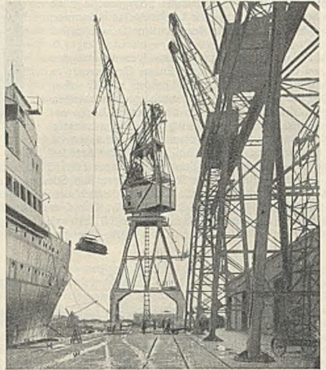
Abb. 40. Le Havre. 5-t-Volltorkran sowie Kranbahn mit nicht drehbaren Kranen am Joannès-Couvert-Kai.
