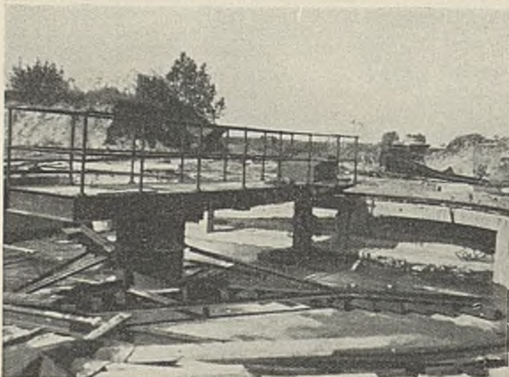
Abb. 36. Nördlicher Sandfang mit Flügelkratzer.
