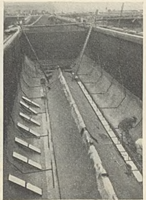
Abb. 39. Verlegung der Filterkasten in einem Belüftungsbehälter.
