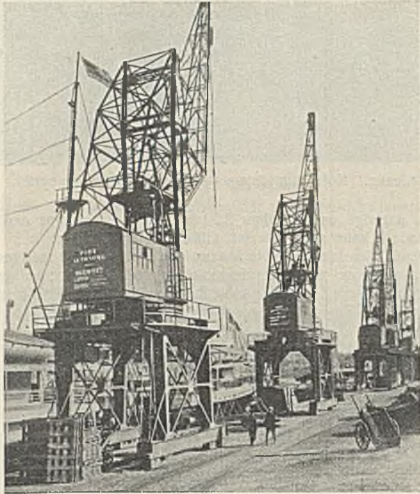
Abb. 39. Bordeaux. Volltorkrane (Bauart Jeumont).
