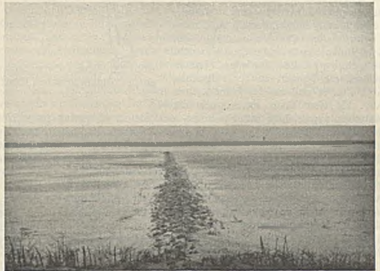
Abb. 37. Umgeänderte Spundwandbühne auf der Insel Trischen.
