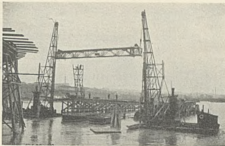
Abb. 10. Aufstellung eines Portalkranes.
