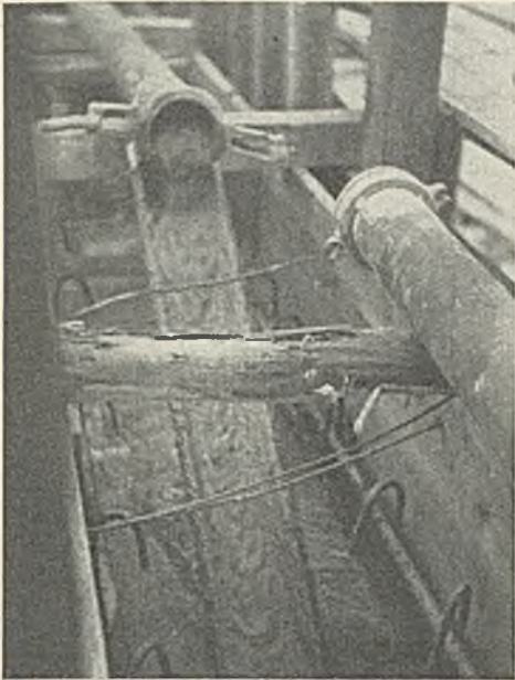
Abb. 29. Der Pumpenbeton verläßt die Rohrleitungen.
