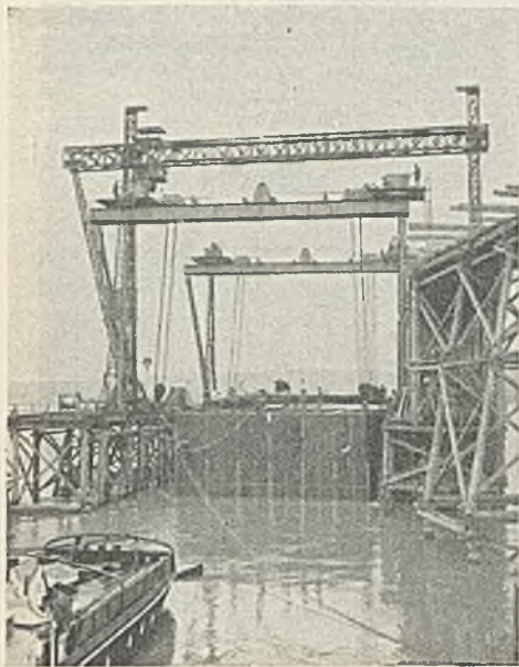
Abb. 9. Ins Wasser gesetzter Senkkasten wird abgeschleppt.
