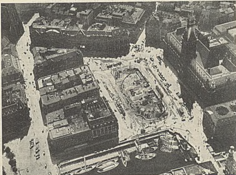
Abb. 7. Flugaufnahme der Anlagen am Reesendamm und des Rathausmarktes während des Umbaus.
