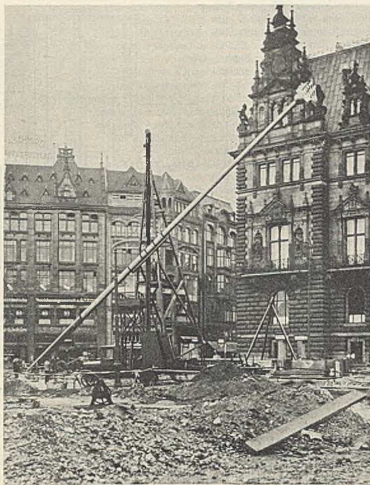
Abb. 10. Versetzen eines Flaggenmastes.
