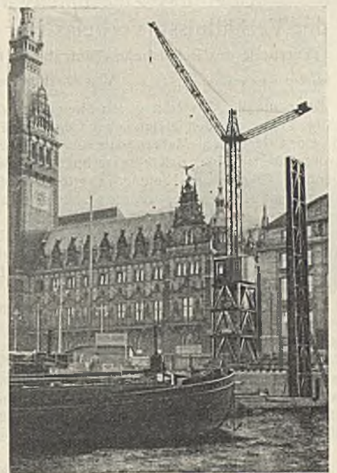
Abb. 8. Aufbau des Stahlgerüsts für das Ehrenmal.
