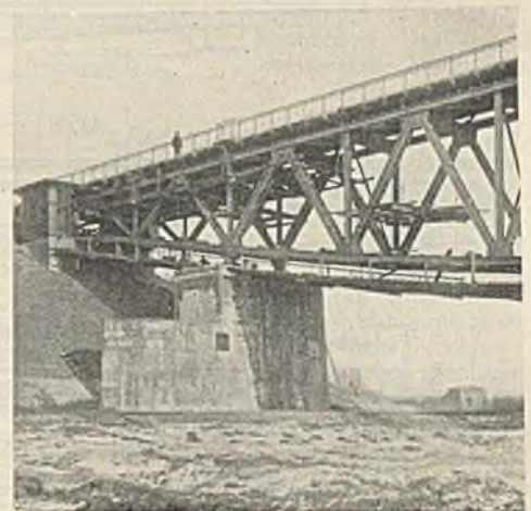
Abb. 5. Teilansicht in Richtung Dt. Rasselwitz mit den drei Plattformen.
