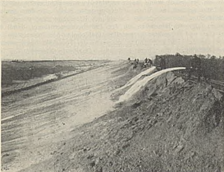
Abb. 9. Spülbetrieb mit Spiralschläuchen.
