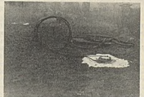
Abb. 11. Eine pneumatische Bodendruckmeßdose nach dem Verlegen auf der Gründungssohle im Senkkasten kurz vor dem Einbetonieren.
