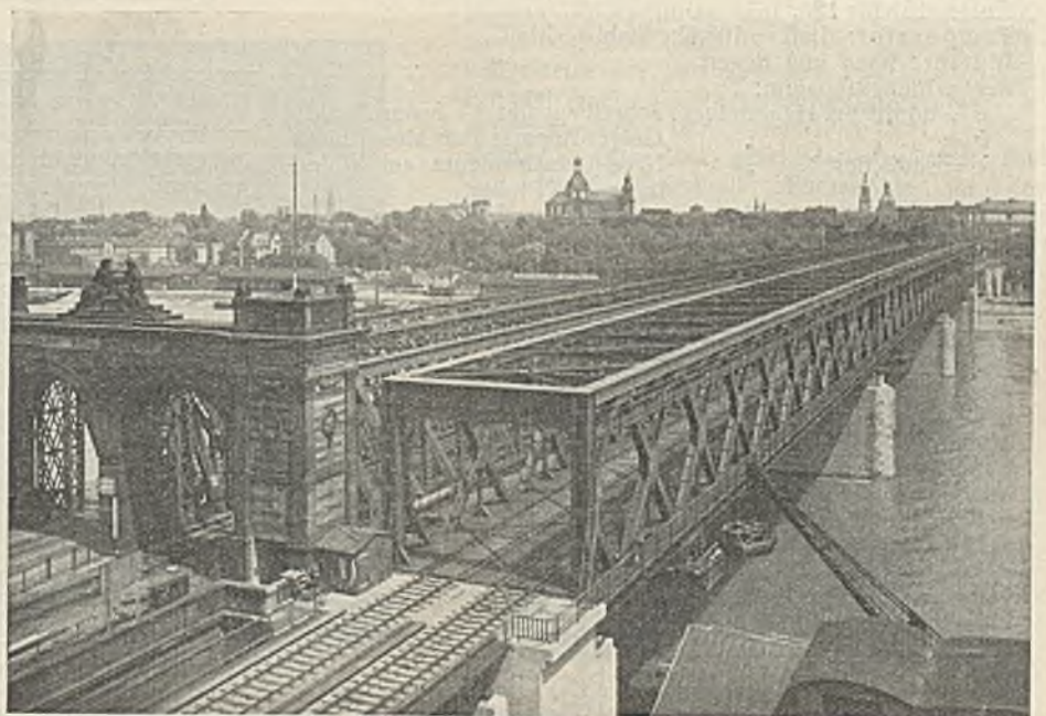
Abb. 2. Gesamtansicht der fertigen Brücke.
