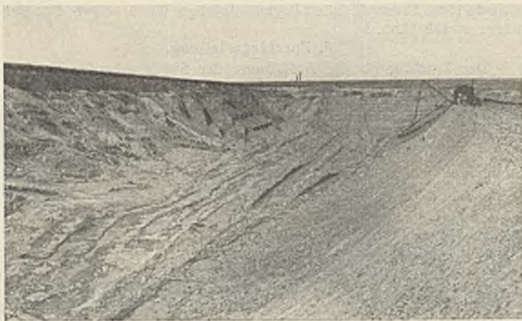
Abb. 15. Baggerung des Dichtungstones.
