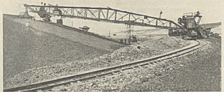
Abb. 17. Tonabsetzer an der 1:3 geneigten Böschung.
