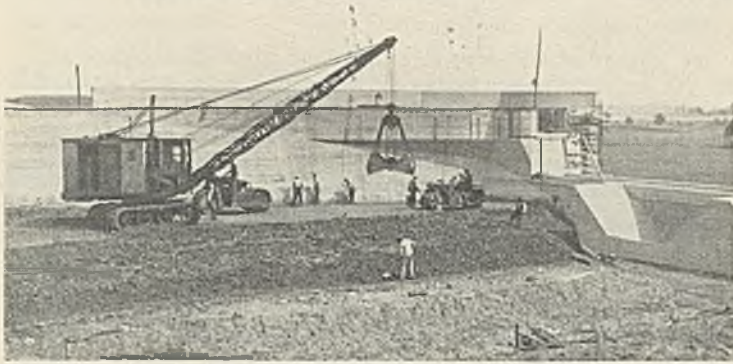
Abb. 18. Toneinbau mit Greifer am westlichen Endwiderlager der Kanalbrücke über die Elbe.
