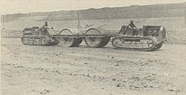
Abb. 20. 7 t schwere Einzelwalzen zwischen Raupenschleppern.
