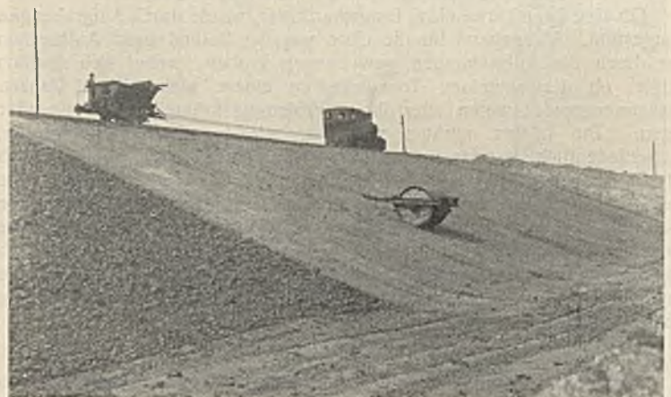
Abb. 21. Walzen der Böschung.
