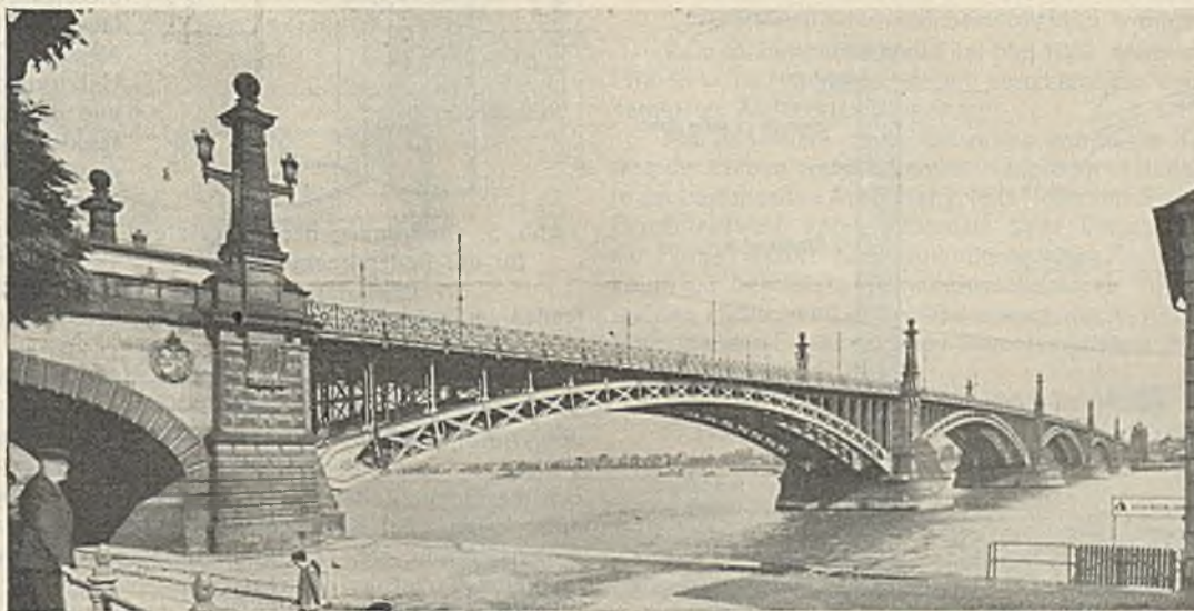
Abb. 2. Ansicht der alten Straßenbrücke.
