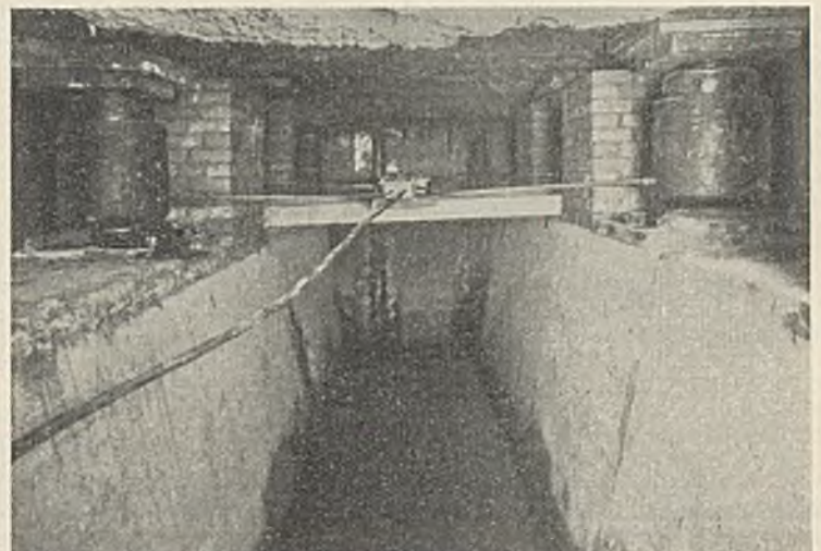
Abb. 17. Anordnung der Pressen im Arbeitsraume vor dem Abpressen.
