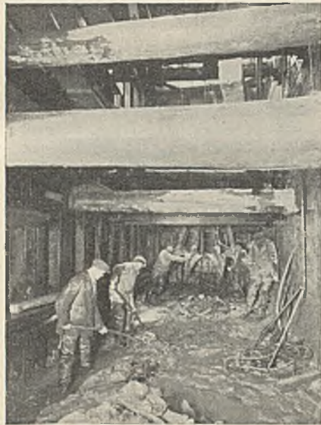
Abb. 12. Ausschachtungsarbeiten in offener Baugrube.
