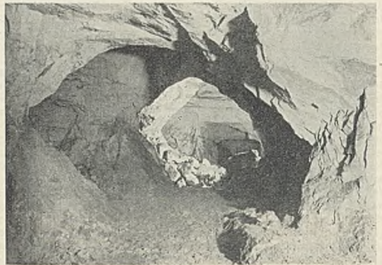
Abb. 2. Druckerscheinung im Einsturzgebiete des St. Pietersberges.
