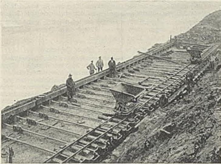
Abb. 28. Verankerung zwischen Uferwand und Ankerwand.
