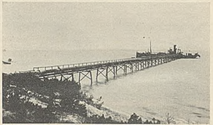
Abb. 8. Anlegestelle und Rohrleitungsbrücke bei Spülfläche VI.
