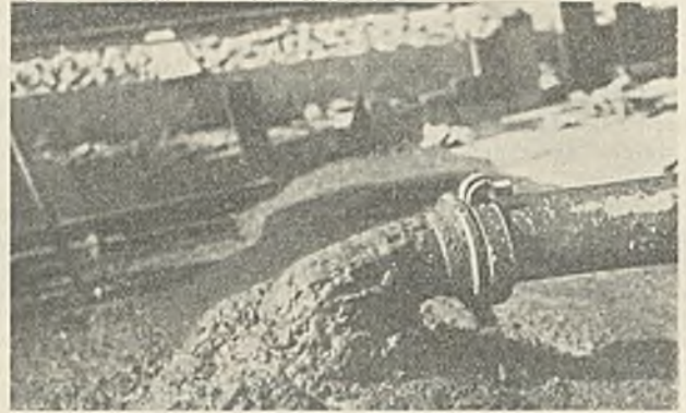
Abb. 7. Betonaustritt, Mischungsverhältnis 1 : 5, rd. 60 % der Zuschläge von 7 bis 50 mm, Leistung rd. 14 m 3 /Std. Brückenbaustelle Ladenburg/Neckar.
