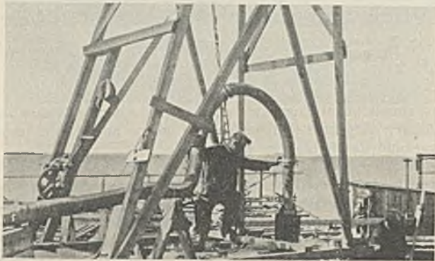
Abb. 3. Ausführung umfangreicher Eisenbeton-Unterwasserbetonierungen im Hafen von Dronthim/Norwegen.
