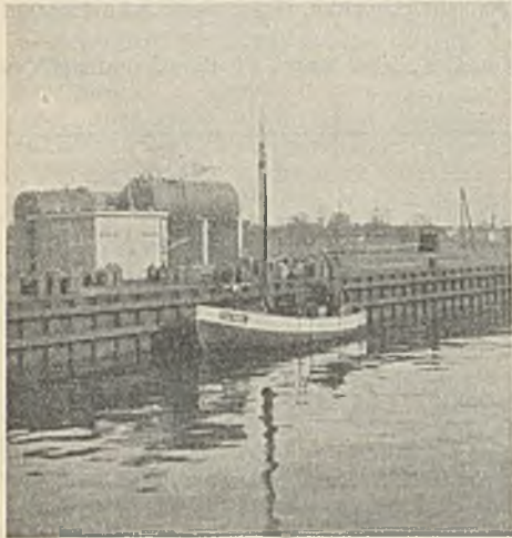
Abb. 1. Kutter Kolberg Nr. 80, 8 m lang, 2,85 m breit, 1,25 m Tiefgang, Motor ursprünglich 4 PS, jetzt 12 bis 15 PS. Gebaut nach 1890 auf Bornholm. Im Hintergrunde die neue Tankanlage der Fischverwertungsgenossenschaft.
