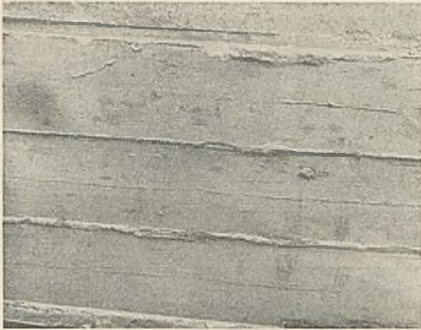
Abb. 9. Freigelegter, unter Wasser mit der Pumpe eingebrachter Beton eines Brückenwiderlagers im Bezirk der RBD Altona.
