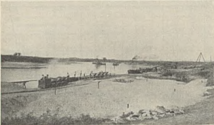
Abb. 15. Deckwerkbau bei Tauschwitz oberhalb Belgern.
