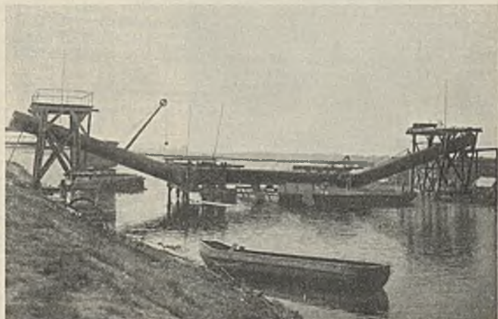
Abb. 19. Mittellandkanal. Einbau des Brechtorfer Dükers.
