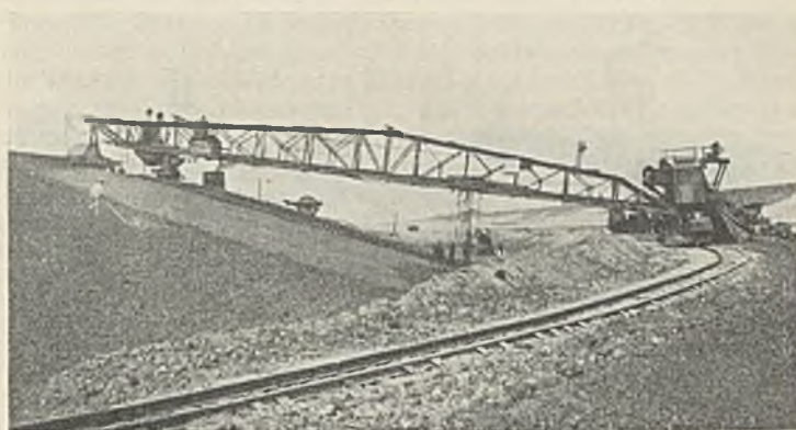
Abb. 20. Mittellandkanal. Tonabsetzer in der Dammstrecke nördlich Magdeburg.
