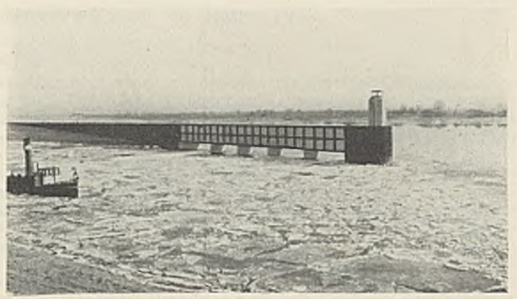
Abb. 22. Mittellandkanal. Mole an der Mündung des Elbabstiegs bei Rothensee.
