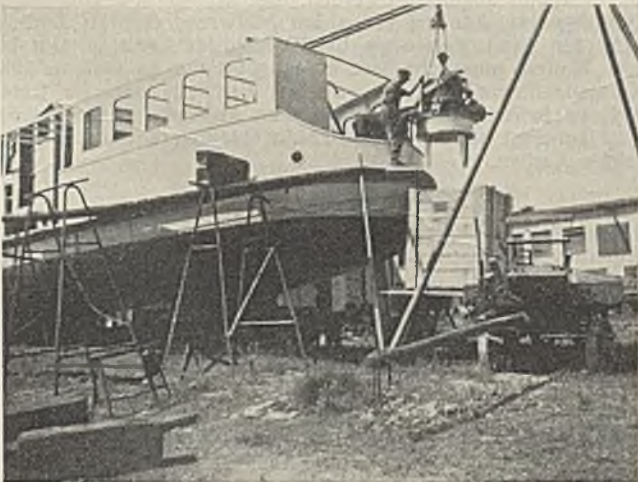
Abb. 4. Einbringen des Propellers in den Schiffskörper.
