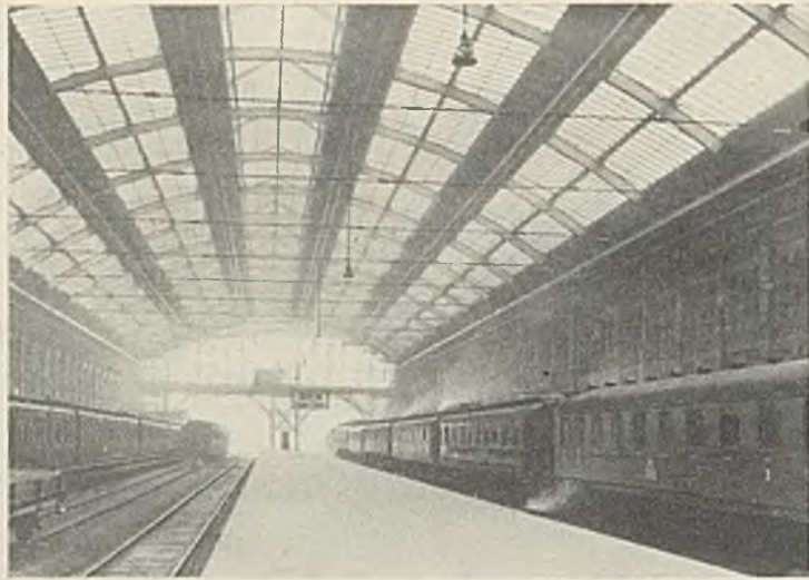
Abb. 15. Halle des Potsdamer Bahnhofes in Berlin.
