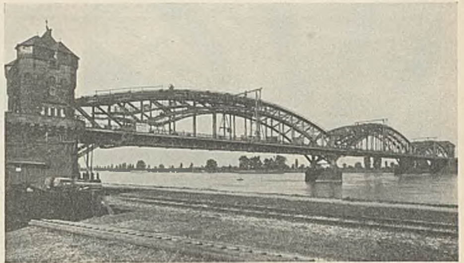
Abb. 10. Rheinbrücke bei Worms.
