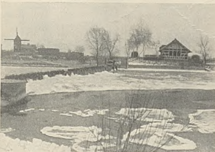
Abb. 10. Wehr Garz bei Treibeis. Oberwasser.
