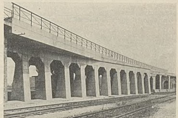
Abb. 14. Östliches Kreuzungsbauwerk auf dem Hannoverschen Bahnhof in Hamburg.
