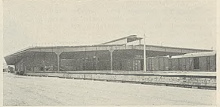
Abb. 16. Geschweißte Güterschuppenbedachung auf Bahnhof Gütersloh.
