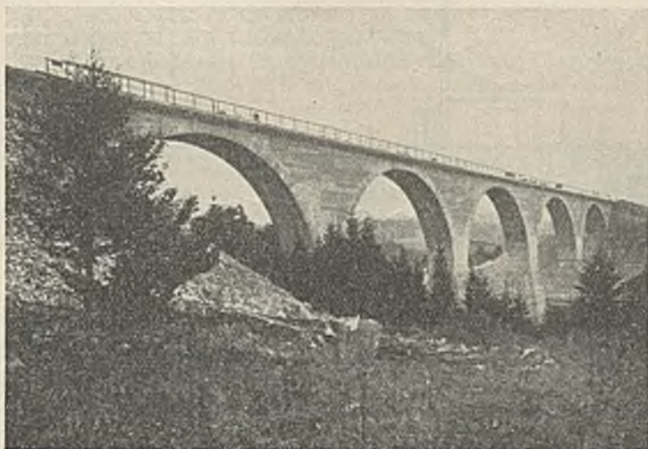
Abb. 13. Viadukt über das EinödtaI.
