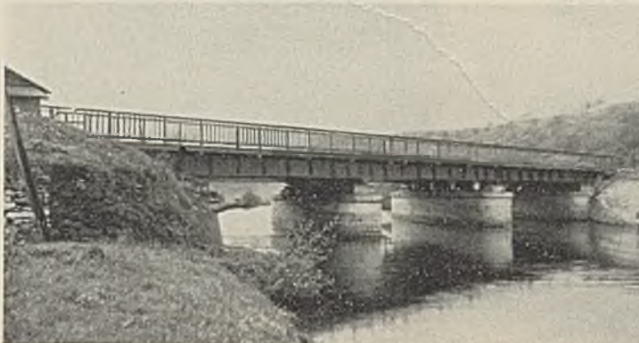
Abb. 3. Siegbrücke bei Eiserfeld. Gesamtansicht.
