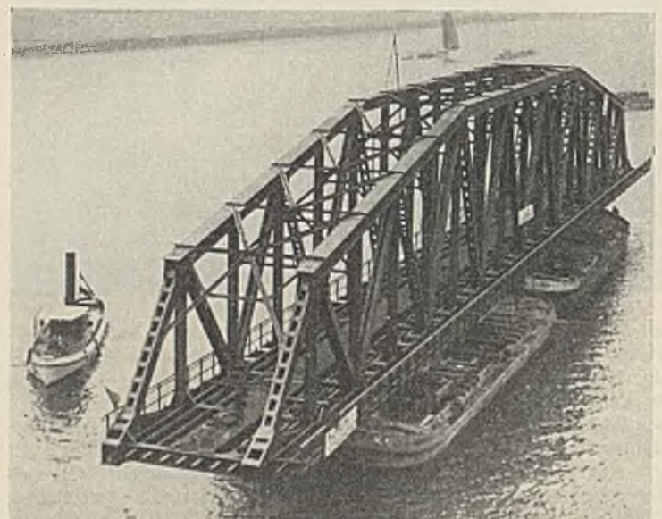
Abb. 2. Die Brücke schwimmend auf Schiffen fertig zum Transportieren.
