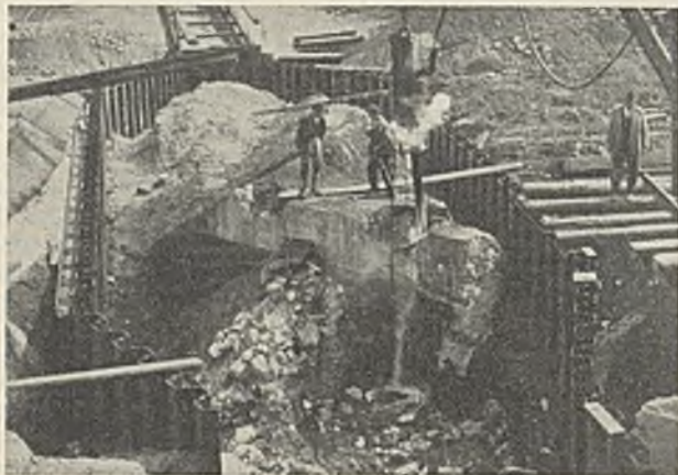
Abb. 11a. Zertrümmerung alter Fundamente mittels des Demag-Union Rammhammers als Meißel.
