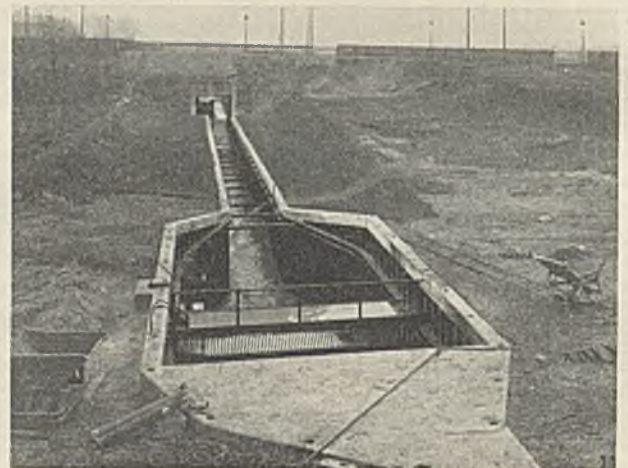
Abb. 11b. Rechenanlage der Alten Emscher stromauf gesehen.
