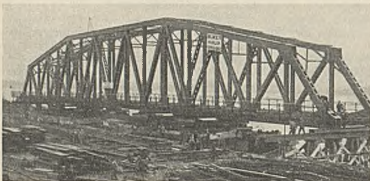
Abb. 1. Fertig montierte Brücke an der Fabrik vorgeschoben über dem Wasser, während des Hebens durch Flut.
