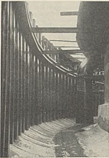
Abb. 11. Blick in den vertieften Pumpensumpf des Pumpwerks „Alte Emscher“. Umfassungspundwand System Larssen IIa.
