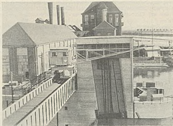
Abb. 25. Umbau des Weserwehres Dörverden. Blick auf den Schleusenpfeiler mit Wehrsteg und Kran.
