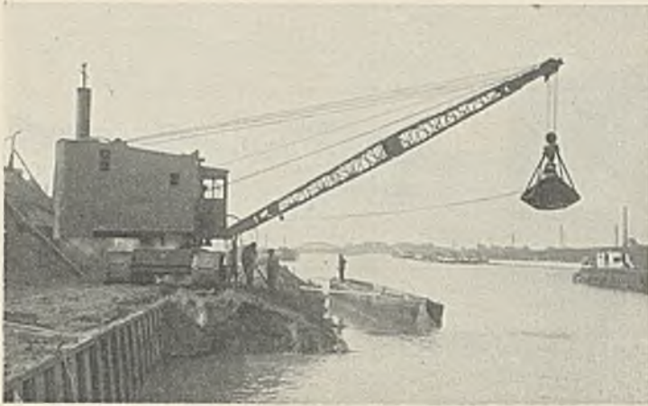
Abb. 26. Herstellung von Liegestellen im Ems-Weser-Kanal oberhalb der Schachtschleuse Minden.
