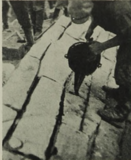
Abb. 10. Abb. 10 u. 11. Vergießen der Fugen des Helmsander Dammes mit seewasserbeständiger Mexphalt-Vergußmasse.
