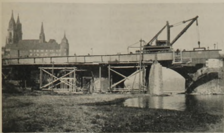
Abb. 4. Bau der Meißener Elbrücke. Montage des Haupttragwerkes (8. 11. 1933).
