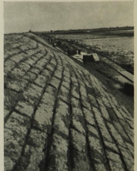
Abb. 10. Abb. 10 u. 11. Vergießen der Fugen des Helmsander Dammes mit seewasserbeständiger Mexphalt-Vergußmasse.
