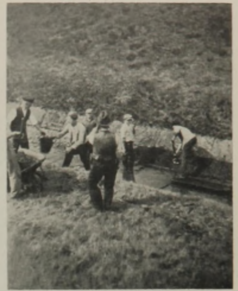
Abb. 7. Stampfen des Asphaltsplittbelages.
