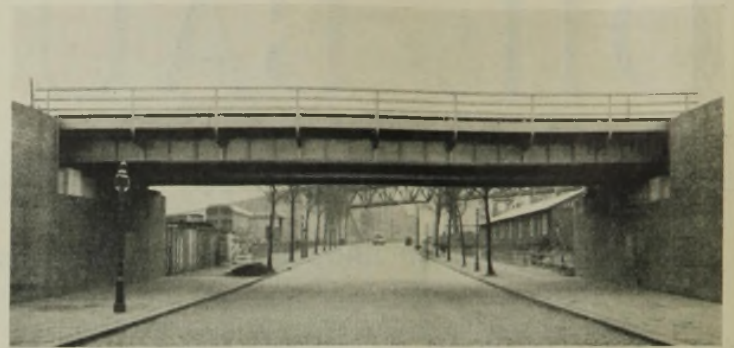
Abb. 6. Unterführung der Hellbrookstraße in Hamburg.
