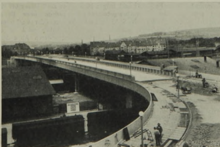
Abb. 3. Blaubeurertorbrücke. Ansicht von oben.
