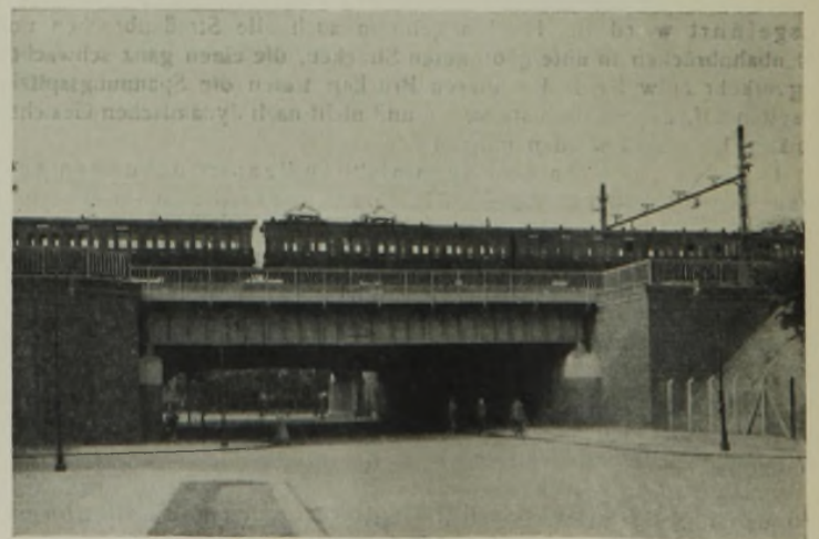
Abb. 5. Unterführung der Hufnerstraße in Hamburg.
