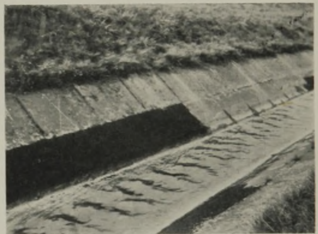
Abb. 8. Asphaltsplitt als Ersatz von Betonplatten auf den Böschungen von Entwässerungsgräben im Ruhrgebiet.
