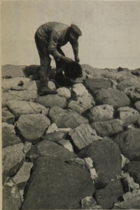
Abb. 12. Vergießen der Steinküste an der Nordsee mit Mexphaltnörtel.
