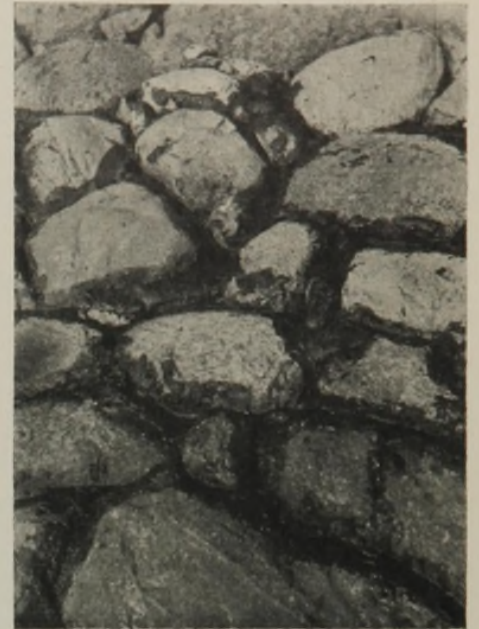
Abb. 13. Die mit Mexphaltnörtel ausgegossene Steinbefestigung der Nordseeküste bei Büsum/Holstein.
