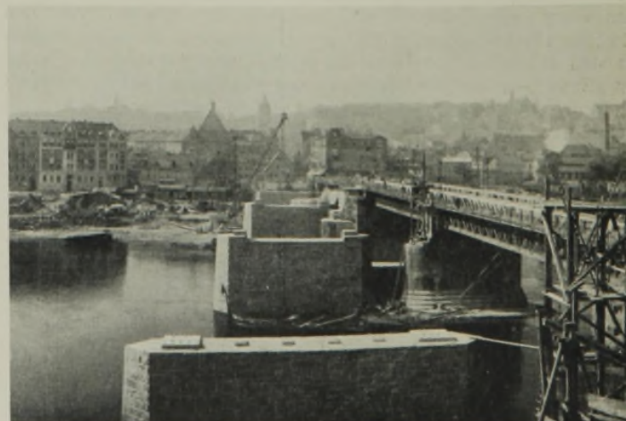
Abb. 3. Bau der Meißener Elbbrücke. Strom- und Landpfeiler (30. 9. 1933).
