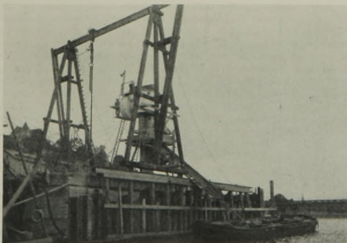
Abb. 2. Bau der Meißener Elbbrücke. Gründung eines Stropfpfeilers mit Senkkasten und Druckluft (7. 7. 1933).
