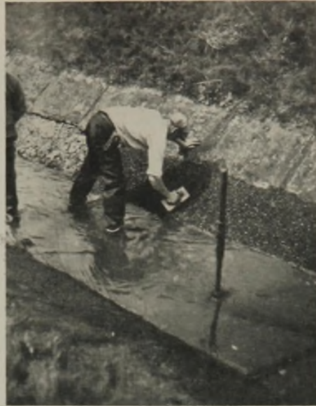
Abb. 6. Ausbreiten des kalt einbaufähigen Asphaltsplitts.
