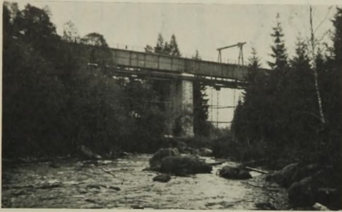
Abb. 2. Eingleisige Eisenbahnbrücke über den Regen.
