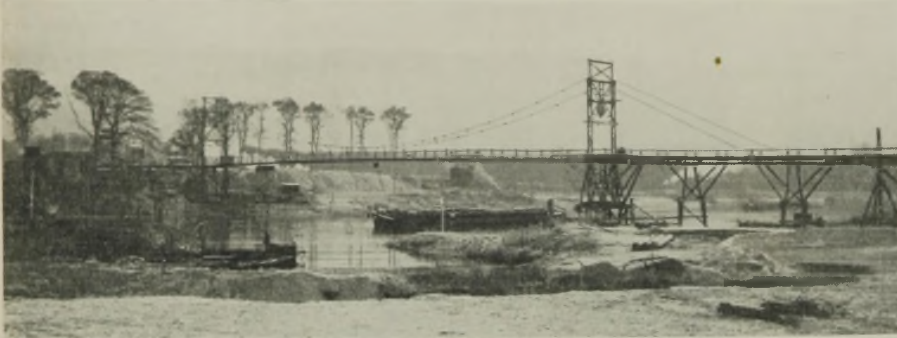
Abb. 10. Durchstich bei Maltsch. Hängebrücke zur Überführung der Spülrohrleitung über die Oder.
