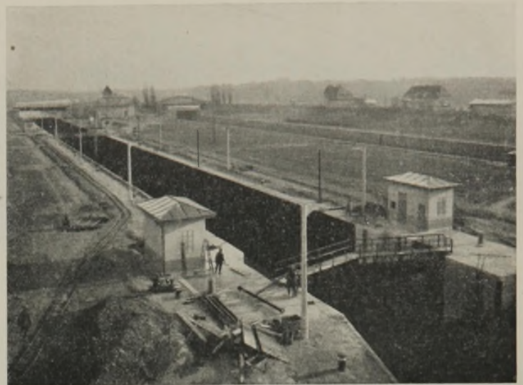
Abb. 9. 2. Schleuse Ransern kurz vor der Füllung (Dezember 1933).
