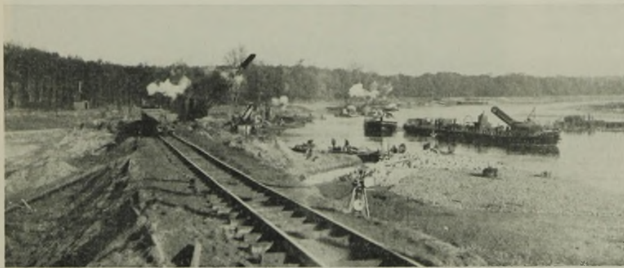
Abb. 11. Durchstich bei Maltsch kurz vor der Öffnung.
