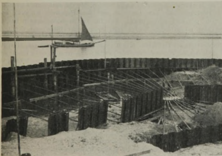
Abb. 1. Schutzbauwerk an der Mellinfahrt. Verankerung einer vorspringenden Eisenspundwand.
