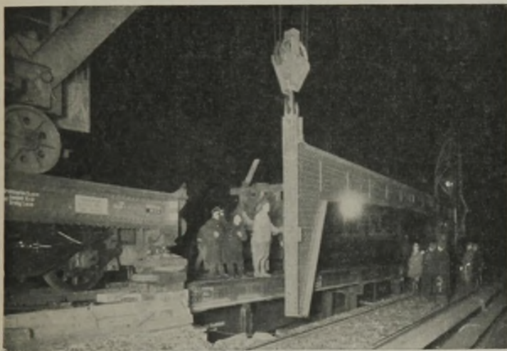
Abb. 19. Einbau eines Zweigelenkrahmens der Unterführung der Lessingstraße in Berlin.
