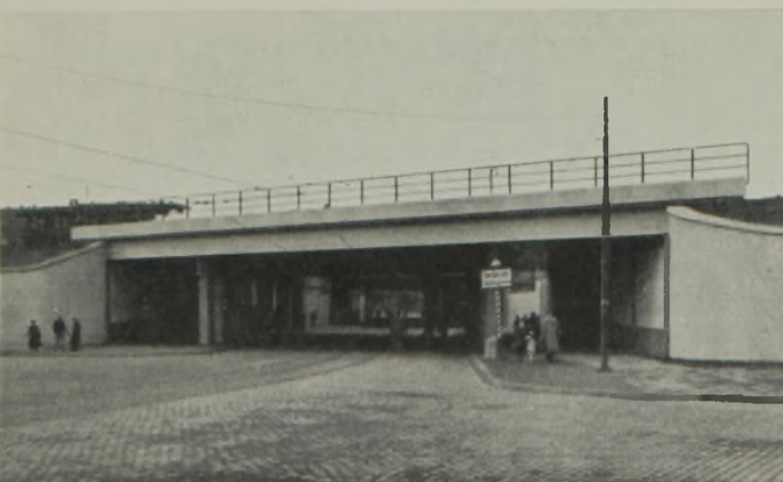
Abb. 13. Unterführung der Ellerstraße in Düsseldorf.
