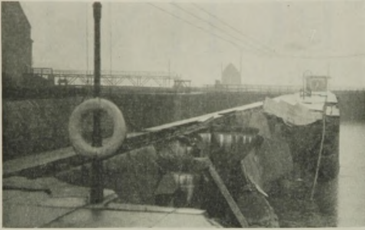
Abb. 2. Bruchstelle vom 9. Febr. 1912 in der Schleusenmittelmauer.
