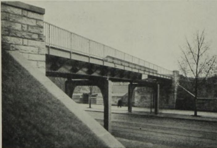
Abb. 14. Unterführung des Breiten Weges in Magdeburg.
