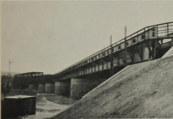
Abb. 7. Saalebrücke bei Großheringen.
