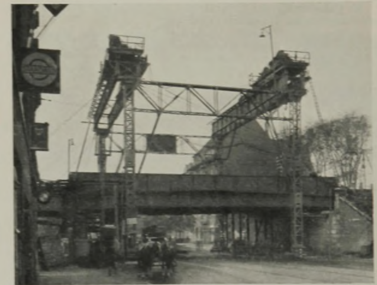
Abb. 10. Umbau der Unterführung der Aachener Straße in Köln.
