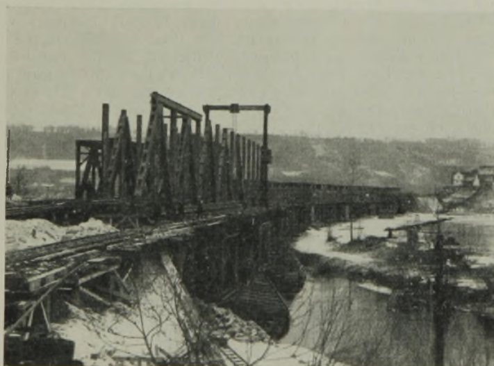
Abb. 24. Überbauten I bis V fertig, Überbau VI in Aufstellung.
