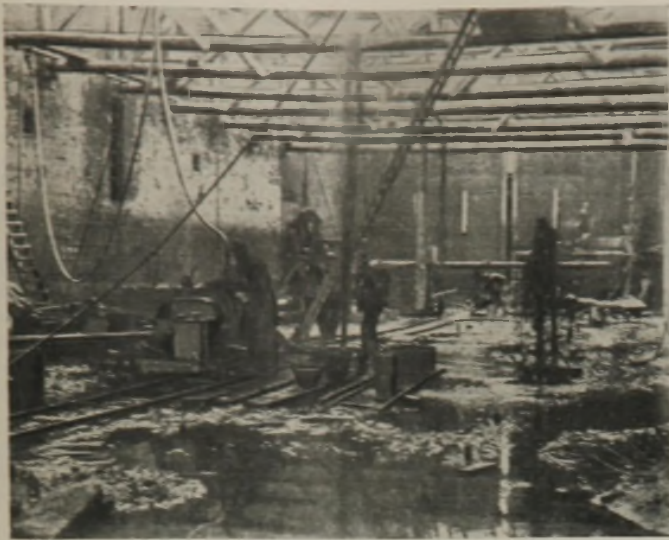
Abb. 11. Ausblasen des schwefelhaltigen Schlammes aus der Schleusensole.
