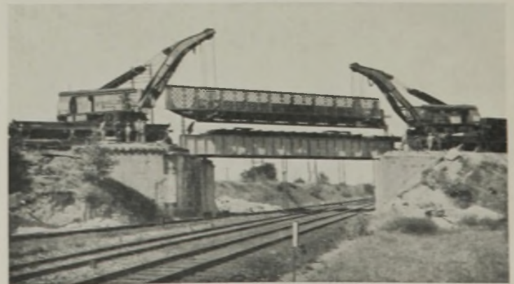
Abb. 9. Kreuzungsbauwerk in Braunschweig. Ausbau eines alten Überbaues.
