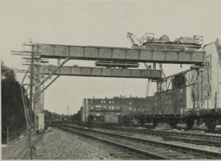
Abb. 11. Umbau der Unterführung der Aachener Straße in Köln.
