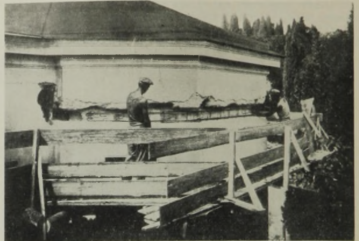
Abb. 13. Schlitze in den Wänden und das Aufstellen der Eisenbetongurte.
