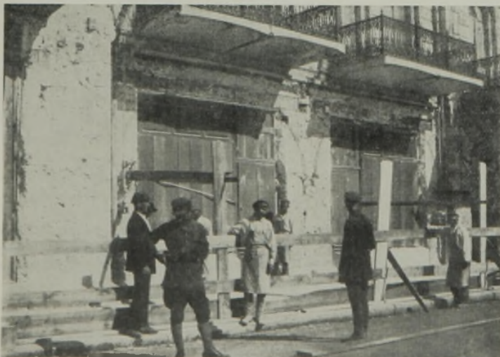
Abb. 15. Ersatz der Bogen durch Eisenbetonbalken.
