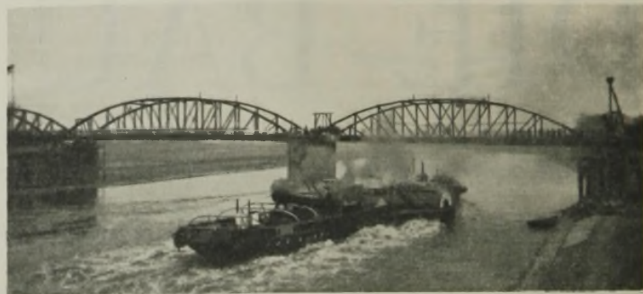
Abb. 17. Elbstraßenbrücke Torgau. Ansicht der Flutbogen vor Beginn der Montagearbeiten der neuen Brücke.
