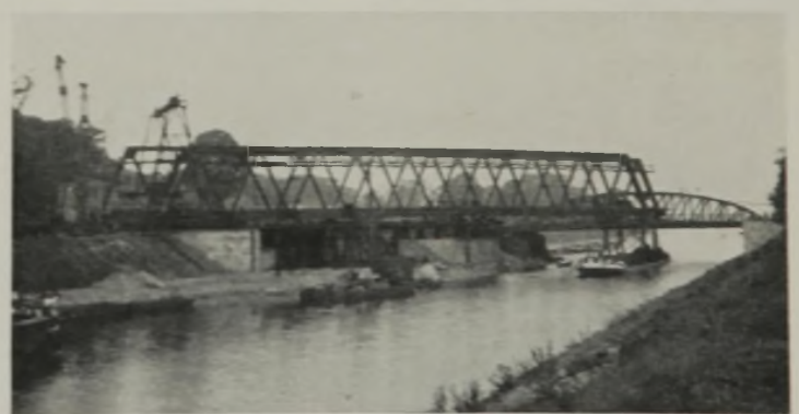
Abb. 14. Einfahren der neuen Brücke bei Nedlitz.
