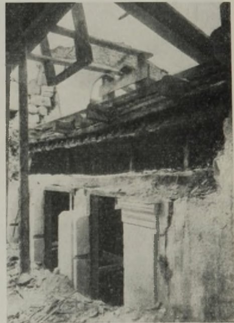
Abb. 11. Das Auseinandernehmen der gerissenen Wände zur Erneuerung. Die Decken sind gepölzt.
