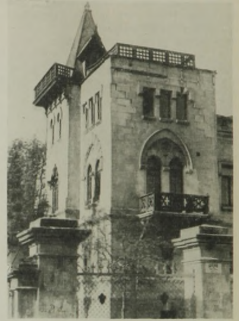
Abb. 5. Abgerutschte Wandsteine der während des Erdbebens in Schwung gekommenen Gebäude.
