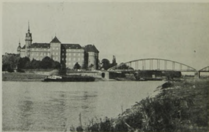
Abb. 18. Elbstraßenbrücke Torgau. Ansicht gegen die neue Strombrücke nach Beseitigung des Strommittelfeilers.
