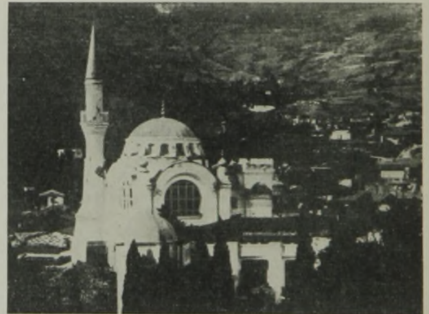
Abb. 6. Das Minarett der Gursufschen Moschee vor dem Erdbeben am 11. September 1927. Es sind Risse im Minarett als Folgen des Erdbebens am 26. Juni 1927 zu sehen.
