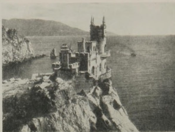
Abb. 9. Die Villa „Schwalbennest“ nach dem Erdbeben 1927 in ihren vorherigen Zustand gebracht.
