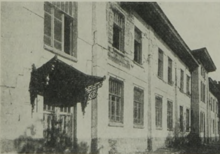
Abb. 3. Parallel dem seismischen Stoß gelegene und dem Zusammenpressen und der Zerstörung ausgesetzte Seitenwand.
