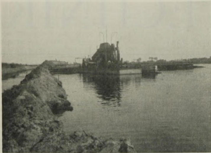
Abb. 15. Untere Havel. Baggerung im Durchstich nach Herstellung der Böschungen durch Landgreifer.
