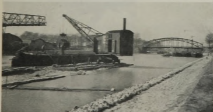
Abb. 13. Verbreiterung des Spandauer Schifffahrtskanals. Landgreifer beseitigt die alte Uferböschung.
