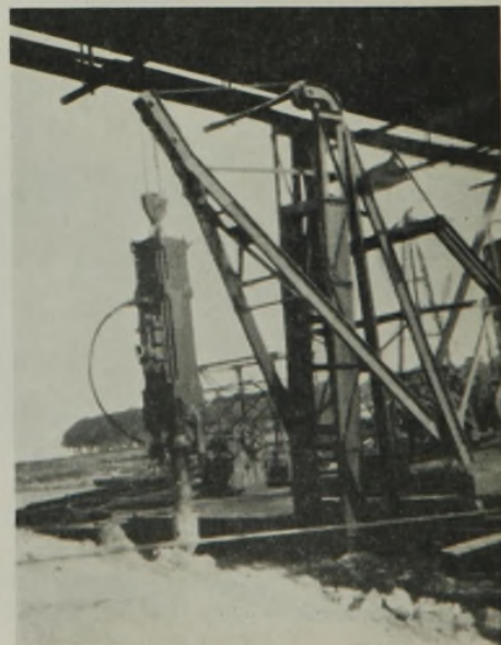
Abb. 19. Elbstraßenbrücke Torgau. Fallmeißel zur Beseitigung der Felssohle.
