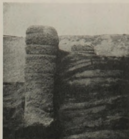
Abb. 12. Ausgegrabener Probepfeiler der Frankbauweise.
