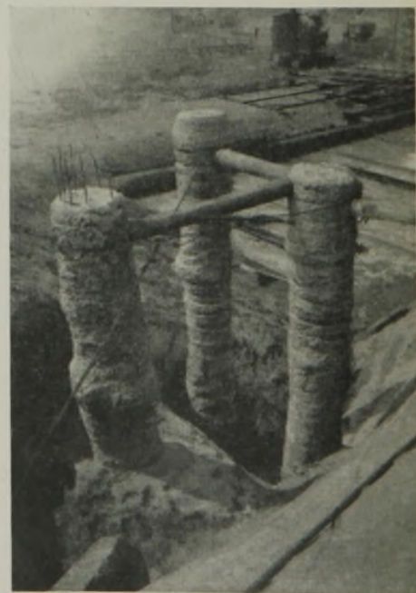
Abb. 10. Ausgegrabene und gegenseitig abgestützte Probelpfähle der Frankibaumweise.
