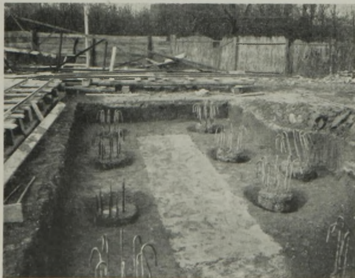
Abb. 9. Gründungssohle mit den Köpfen der Frankipfähle.
