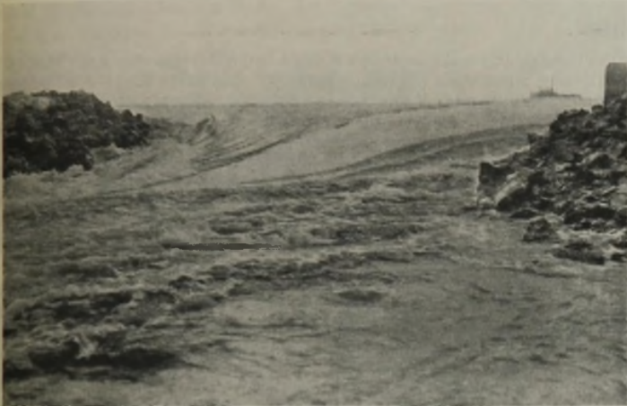
Abb. 1. Ebbeströmung durch die Deichlücke am Vormittag des Zusammenschlusses.
