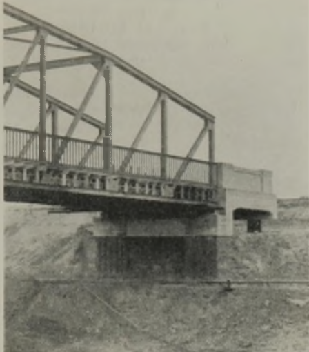
Abb. 7. Feldwegbrücke über den Mittellandkanal. Das fertige Widerlager mit dem stählernen Überbau.
