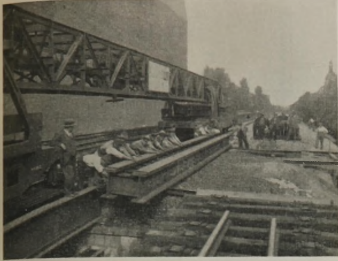
Abb. 10. Einbau der Seitengleisbrücken.
