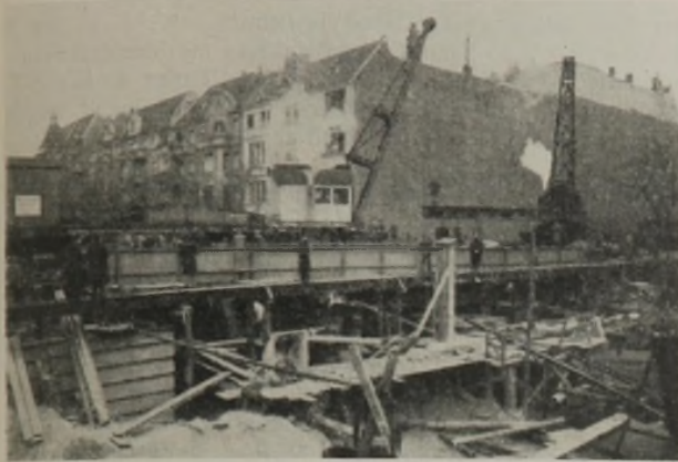
Abb. 19. Ausbau der Behelfskonstruktion.
