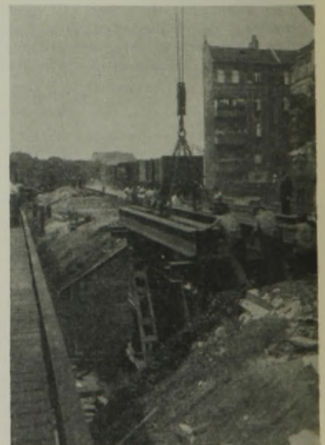
Abb. 9. Einbau der Mittelgleisbrücke.
