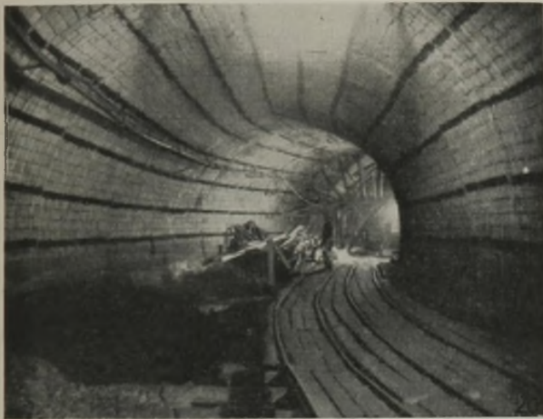
Abb. 1. Füllortanlage auf Zeche Osterfeld in Herzbruchschem Keilkranzausbau.
