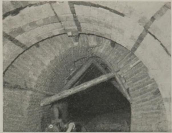
Abb. 16. Ersatz eines zerstörten Ziegelmauerwerks durch Keilkranzausbau, ohne Mehrausbruch von Gebirge.
