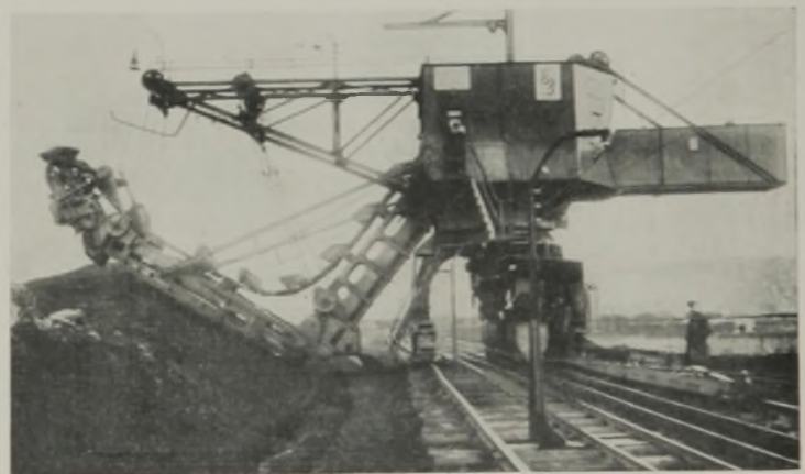
Abb. 1. Auf Schienen fahrender Eimerkettenbagger vor dem Umbau.
