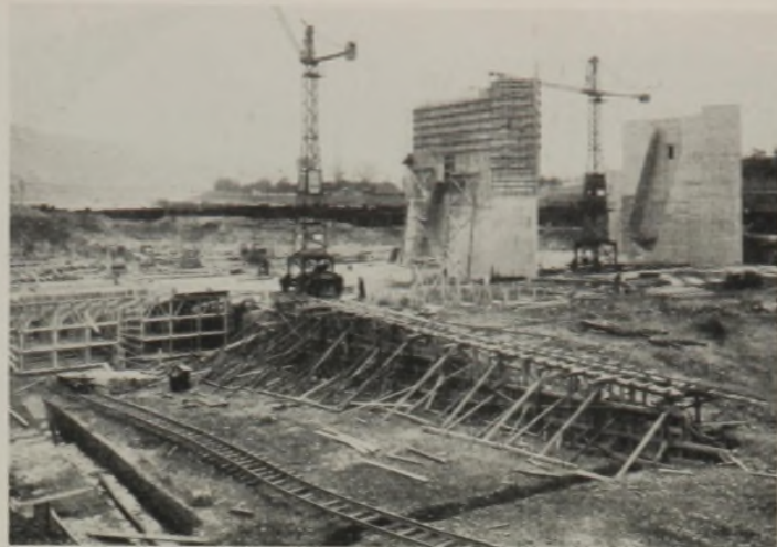
Abb. 73. Staustufe Neckarzimmern. Flußverbreiterung mit zwei Wehröffnungen und dem Kraftwerk im Bau (flußauf gesehen).
