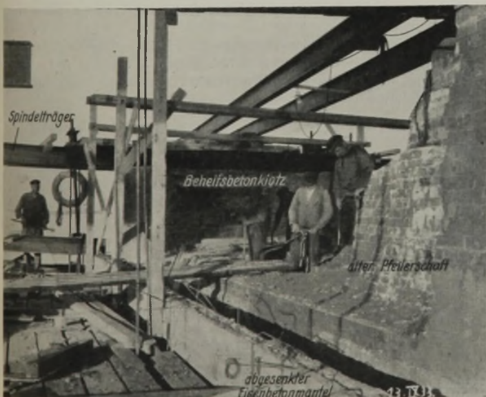
Abb. 2. Alter Pfeiler mit dem neuen Mantel und der Aufhängevorrichtung auf dem Behelfsbetonklotz.
