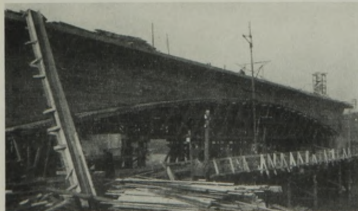
Abb. 77. Staufstufe Münster. 2. Bauteil. Straßenbrücke unterhalb Münster im Bau.
