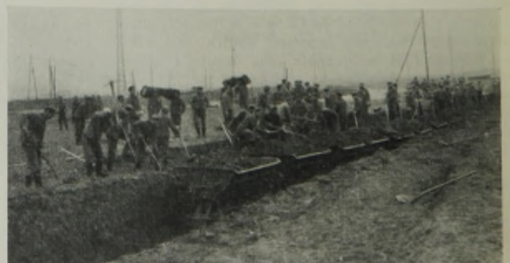
Abb. 79. Staufstufe Altbach-Plochingen (Deizisauer Durchstich). Freiwilliger Arbeitsdienst am Handschacht.
