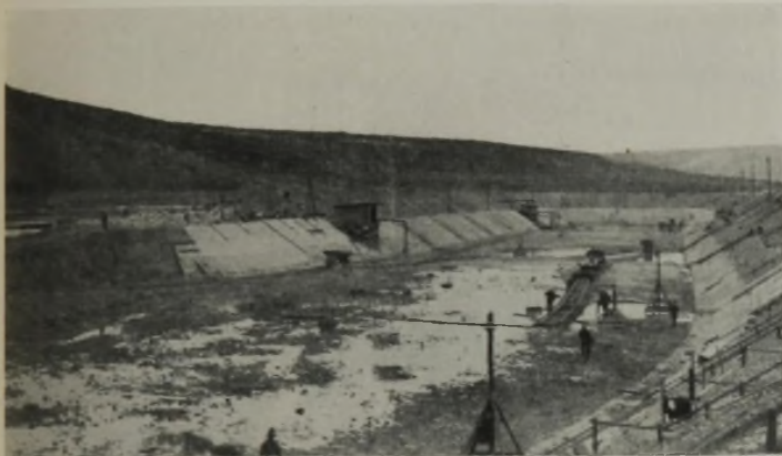
Abb. 66. Schutzhafen Wertheim im Bau, von der Hafeneinfahrt aus gesehen.
