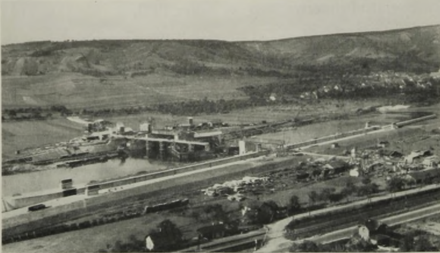
Abb. 67. Staustufe Erlabrunn. Gesamtansicht der Baustelle Oktober 1933.
