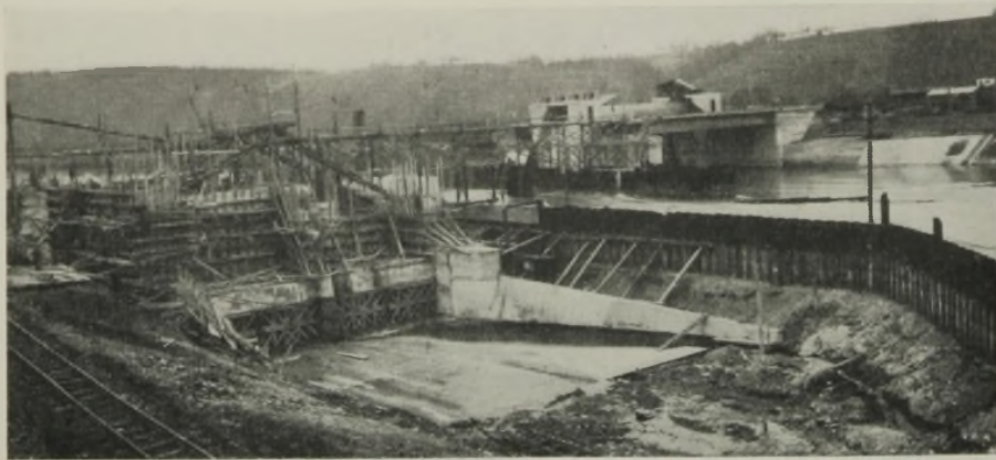
Abb. 76. Staufstufe Münster. 2. Bauteil, I. Wehröffnung mit Straßenbrücke am linken, Kraftwerk am rechten Ufer im Bau (flußauf gesehen).
