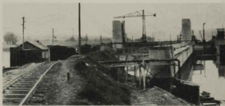
Abb. 74. Staustufe Gundelsheim. Schleuse und linke Wehröffnung im Bau (flußauf gesehen).
