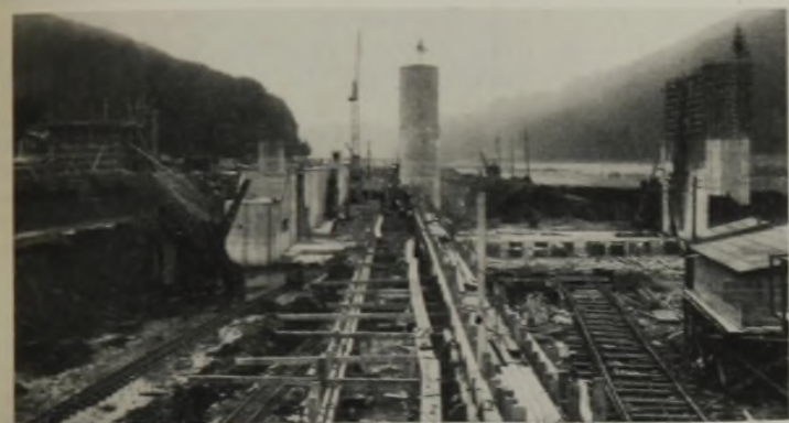
Abb. 72. Staustufe Guttenbach. Schleuse und I. Wehröffnung am rechten Ufer im Bau.
