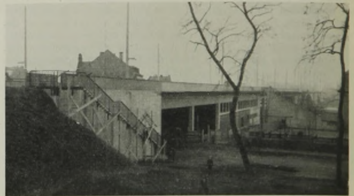
Abb. 11. Die in dem Bauteil C der Rampenbrücke eingebaute Turnhalle und die Treppenanlagen an der Metternicher und der Weinbergstraße.
