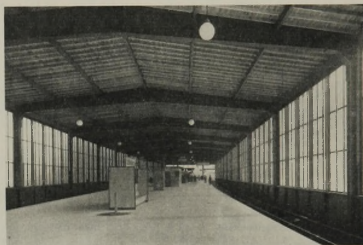
Abb. 36. Geschweißte Halle des Ringbahnhofs Schöneberg.
