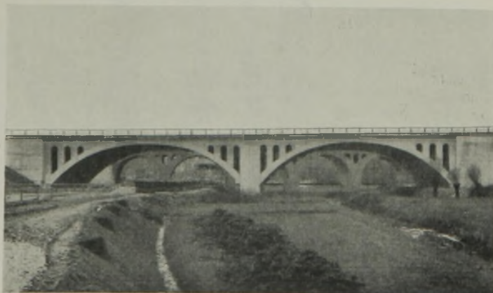
Abb. 31. Lungwitzbachbrücke in Glauchau.
