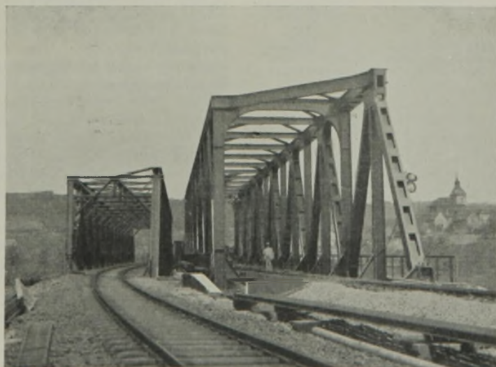
Abb. 21. Saalebrücke bei Großheringen.
