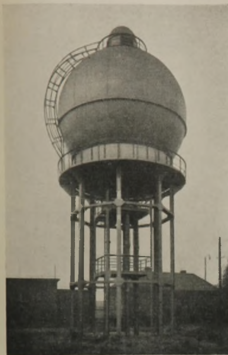
Abb. 34. Geschweißter Wasserturm auf Bahnhof Dortmund.
