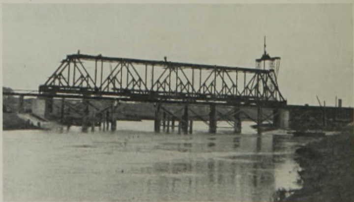
Abb. 22. Warthestrombrücke bei Schwerin.
