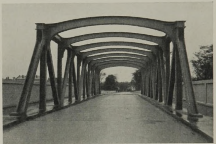
Abb. 25. Überführung der Schönstraße in Breslau.
