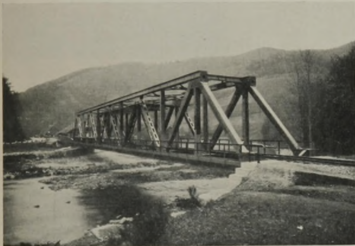
Abb. 24. Kinzigbrücke bei Halbmeil.
