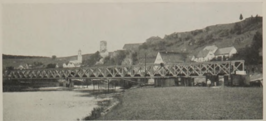
Abb. 23. Donaubrücke bei Rechtenstein.
