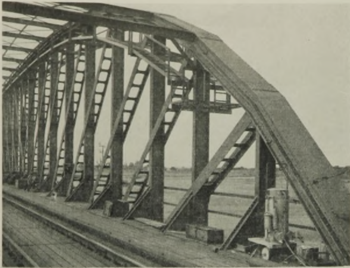
Abb. 27. Elbebrücke bei Dömitz. Verstärkter Überbau.
