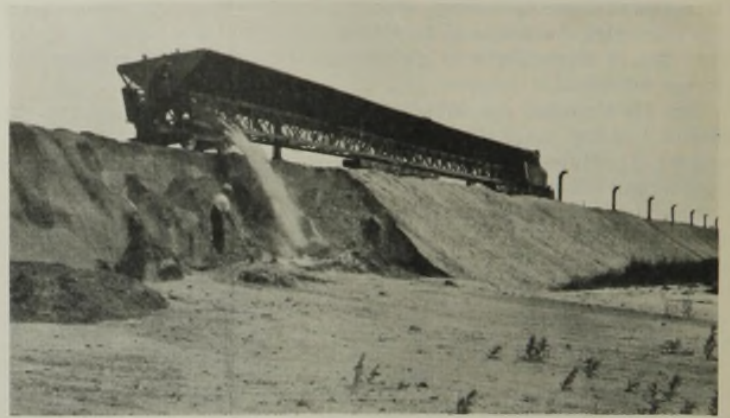
Abb. 26. Erdarbeiten im Los M 2 (Magdeburg) des Mittellandkanals. Einschlämmen des Bodens mittels eines Wasserrinnenwagens, der im Fahren aus einer Rohrleitung gespeist wird.
