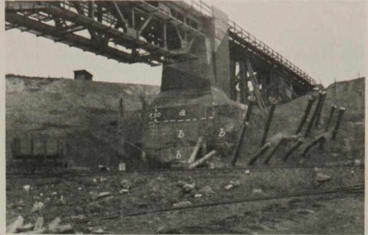
Abb. 31. Eisenbahnbrücke Gifhorn—Braunschweig. Freigelegtes Widerlager, anschließende Behelfsbrücke.
