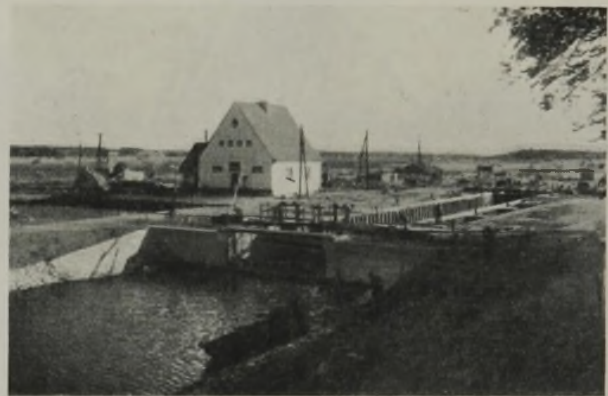
Abb. 24. Staustufe Bardowick. Schleuse mit Wärterhaus. Ansicht vom Unterwasser.
