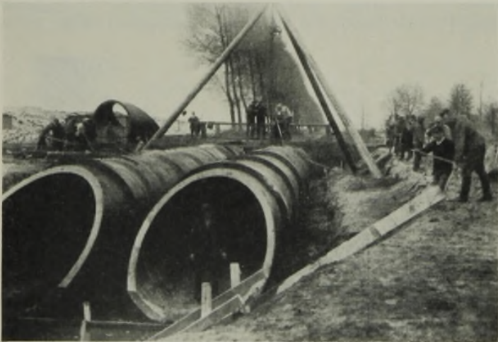
Abb. 27. Verlegen von Schleuderbetonmuffenrohren von 2 m Durchm. für die Durchführung des Mittelgrabens durch eine Brückenrampe.
