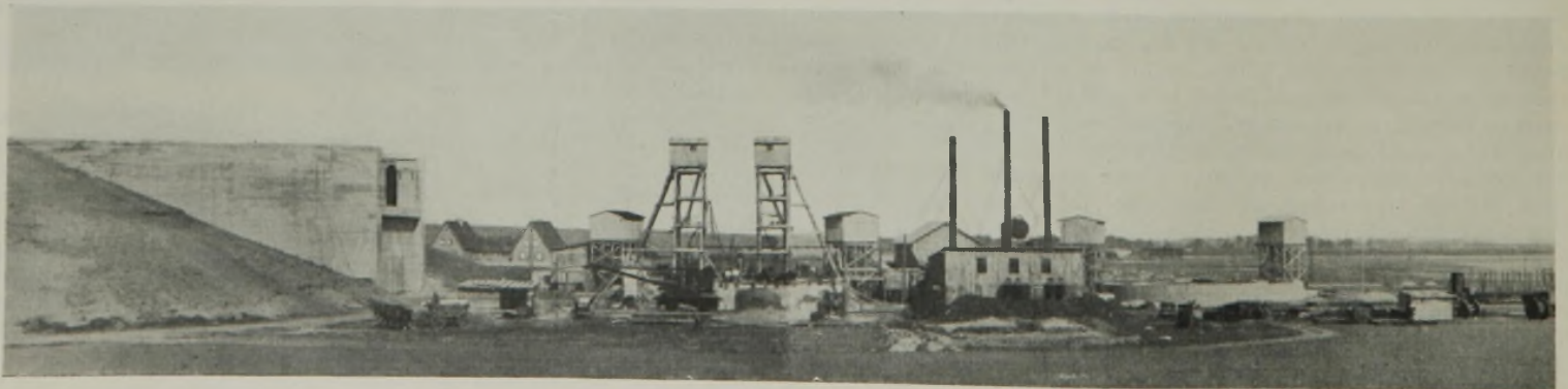
Abb. 29. Hebewerk Rothensee. Gesamtansicht der Baustelle für die Schwimmerschächte mit Dammschlußmauer.
