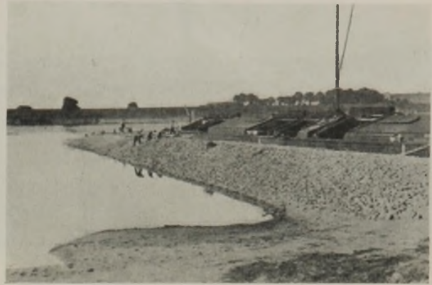
Abb. 22. NW-Regulierungsarbeiten bei Lauenburg. Abdecken einer Buhne mit Steinschüttung.
