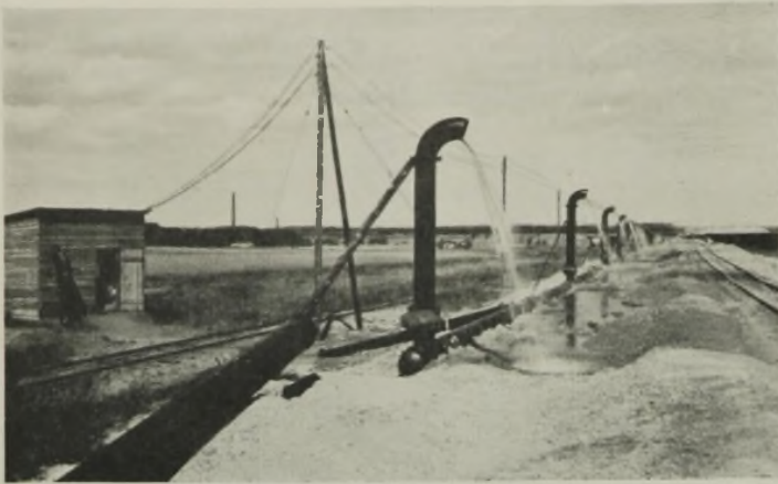
Abb. 25. Erdarbeiten im Los M 2 (Magdeburg) des Mittellandkanals. Sumpfen des ersten Spüldammes.
