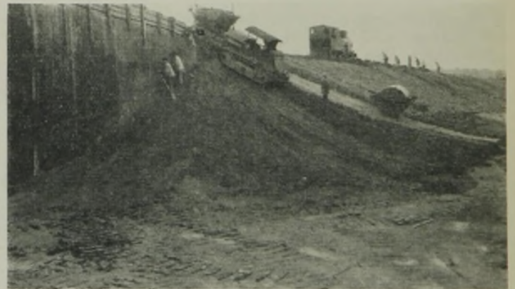
Abb. 43. Einbringen der Tondichtung beim Anschluß an einen Flügel der Kanalüberführung.
