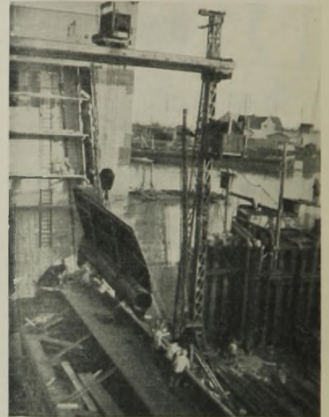
Abb. 38. Weserwehr Dörverden. Montage der Eisklappe auf das 24,9-m-Dreigurtschütz.
