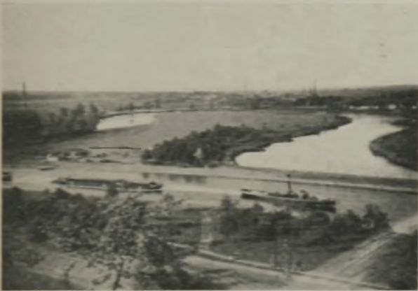
Abb. 32. Durchstich bei Alsleben an der Saale.
