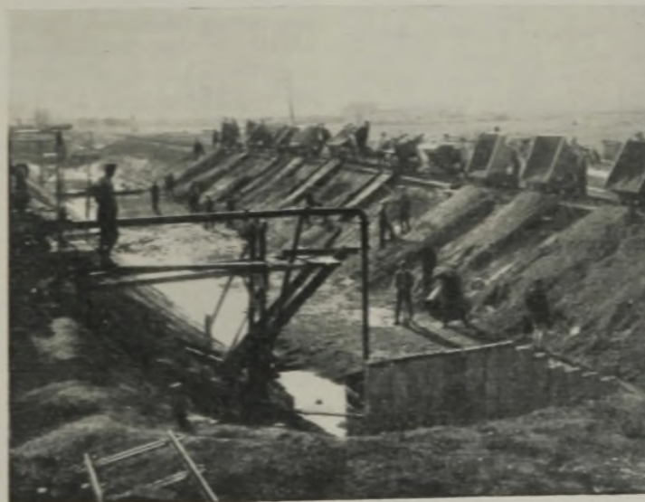
Abb. 34. Zschampert-Durchlaß am Elster-Saale-Kanal. Verfüllen der ausgehobenen Baugrube mit Kies.
