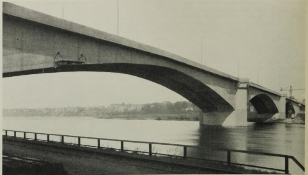
Abb. 6. Ansicht der Brücke von Unterstrom, gesehen in der Brückenachse.
