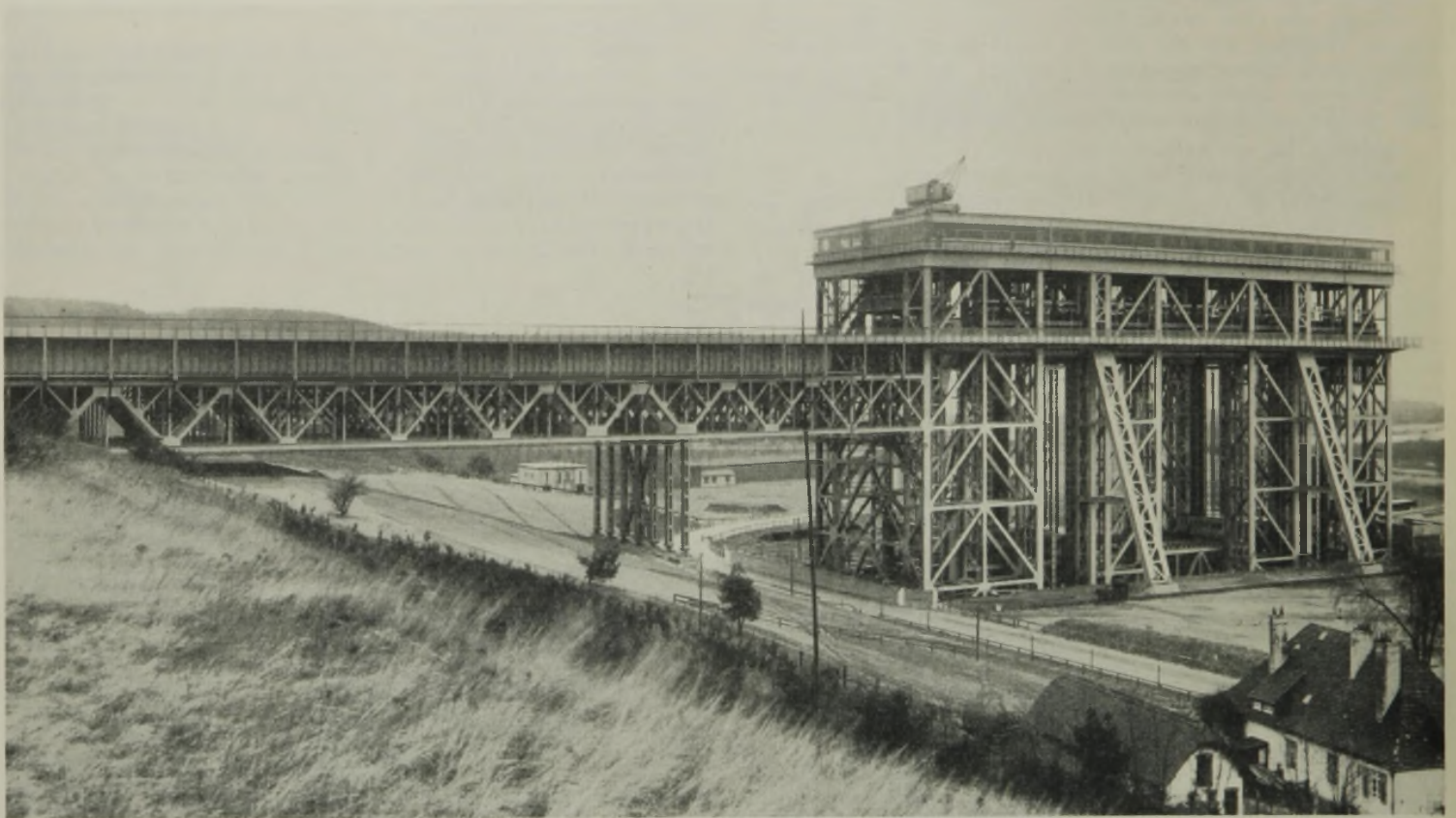
Abb. 6. Ansicht von Südwesten (Februar 1934).
