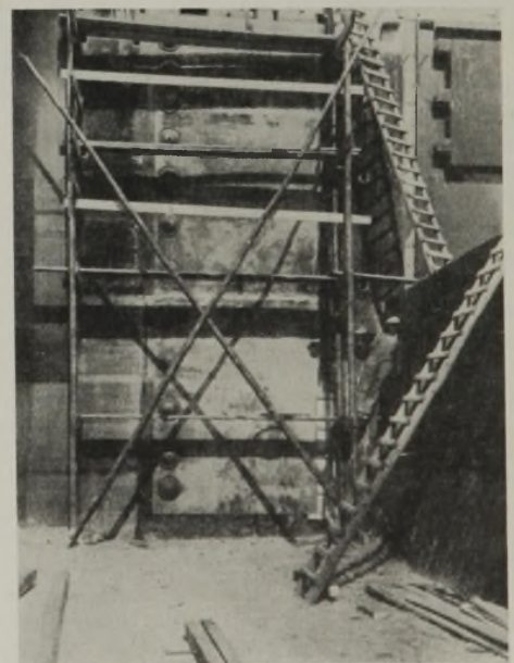
Abb. 34. Abdichtung der Trennungsfuge zwischen Widerlager und Flügel. Kanalseitige Ansicht nach dem Einbau der Kupferschürze.
